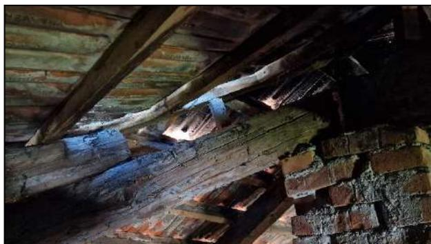
*Carenze strutturali/costruttive delle connessioni lignee*
