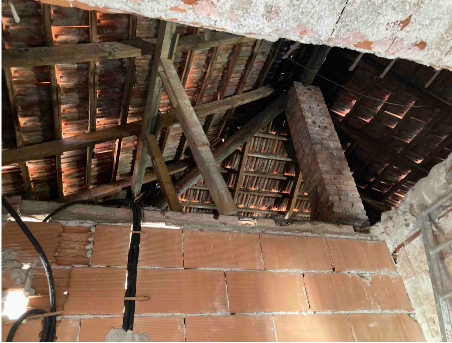
Vista interna: vista della copertura (immagine fotografica del 2022)
