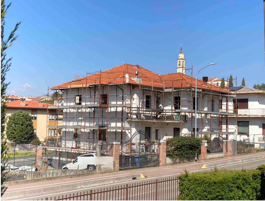
Vista dell' immobile da via San Giuseppe (immagine fotografica del 2024)
