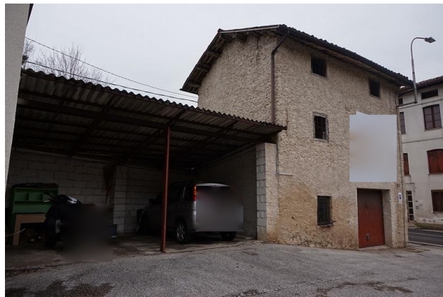
Fronte sud da area manovra (Particella n.1143)
