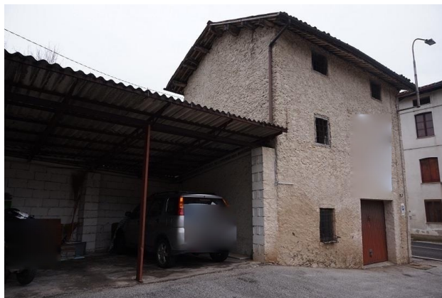
Fronte sud da area manovra (Particella n.1143)
