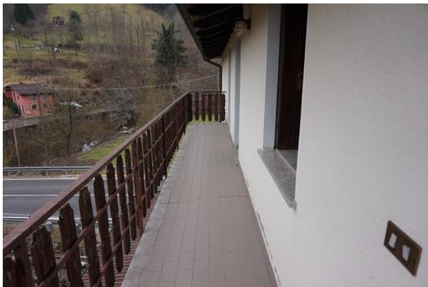
Piano secondo – Terrazzo a sud da est verso ovest
