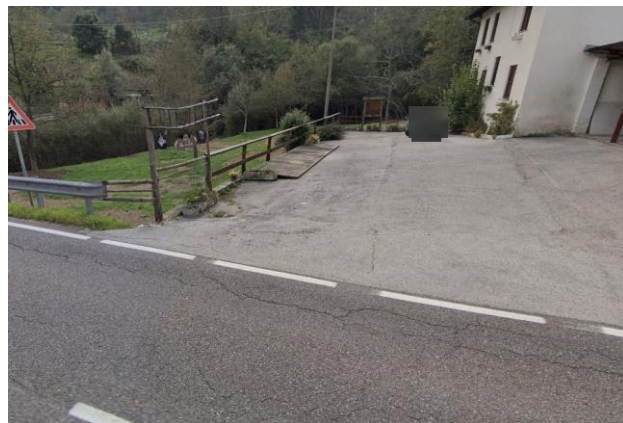
Vista da est verso ovest
