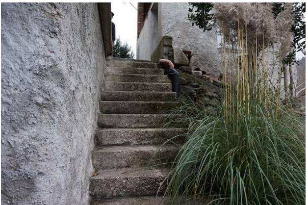
Scala esterna ad est tra piano terra e interrato
