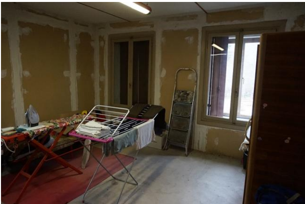
Piano primo – Stanza a sud/ovest
