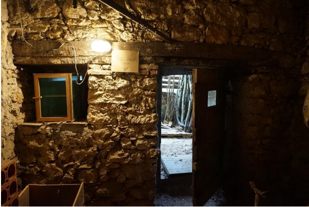
Vista ingresso da nord verso sud
