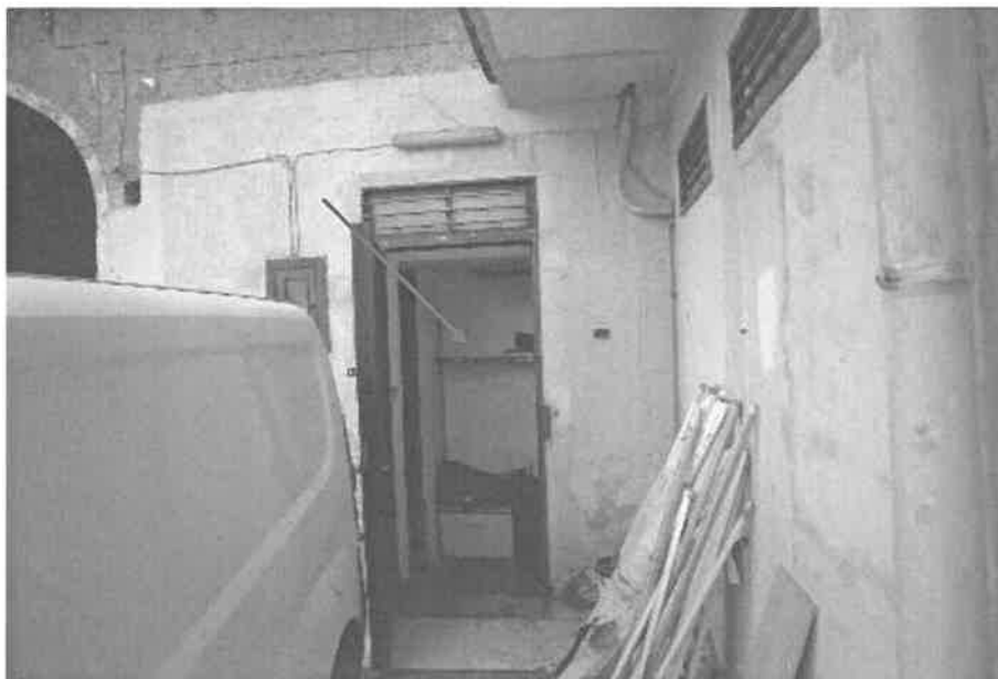
VISTA DELL'INGRESSO AL LOCALE DALLA CORTE COMUNE
