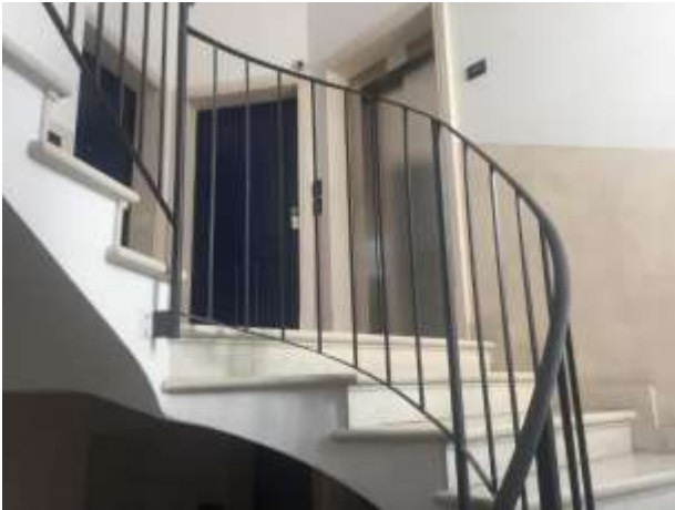
- Veduta scala condominiale interna
