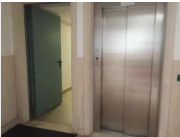
- Veduta accesso condominiale alle autorimesse
