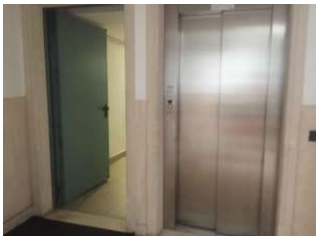
- Veduta accesso condominiale alle autorimesse
