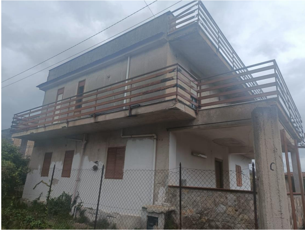
Foto 1-2. Viste esterne del fabbricato.
