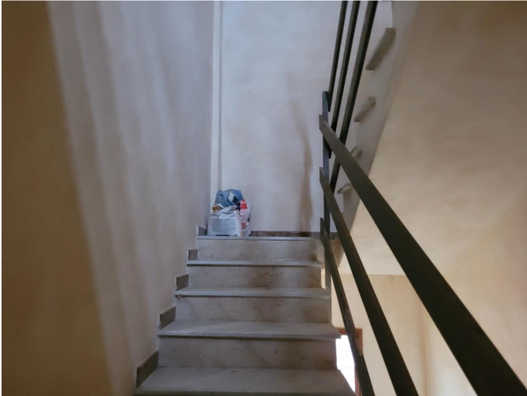
Foto 10. Scala che conduce al piano primo e al lastrico solare
