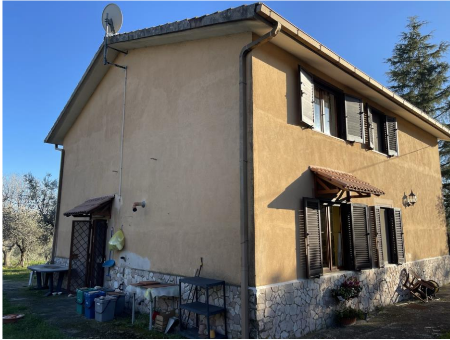
Fotografia n.4 – Il fabbricato staggito censito al Foglio n.6, Particella n.107 ripreso dallo spigolo Nord-Ovest.
