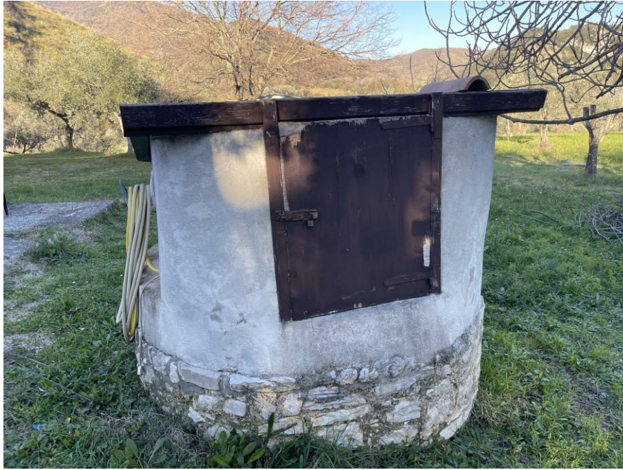
Fotografia n.12 – Corte esterna – Il manufatto “Copertura Pozzo” ricompreso all’interno della corte esterna di pertinenza del fabbricato censito al Foglio n.6, Particella n.107.
