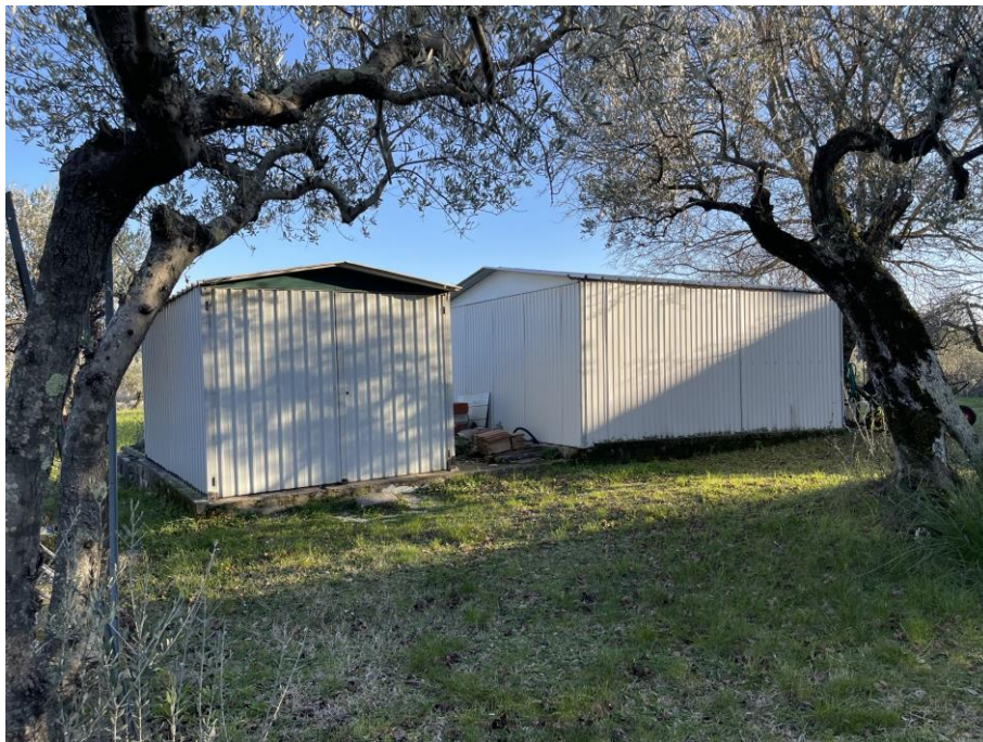
Fotografia n.13 – I due manufatti adibiti a magazzini ricompresi all’interno della Particella di terreno censito al Foglio n.6, Particella n.59.
