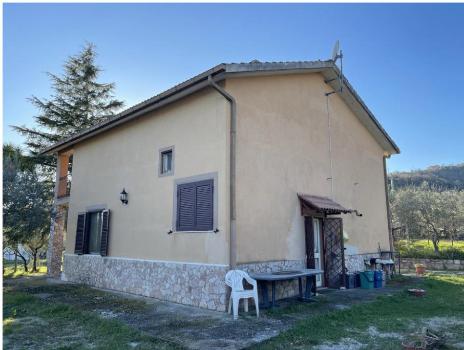
Fotografia n.3 – Il fabbricato staggito censito al Foglio n.6, Particella n.107 ripreso dallo spigolo Nord-Est.
