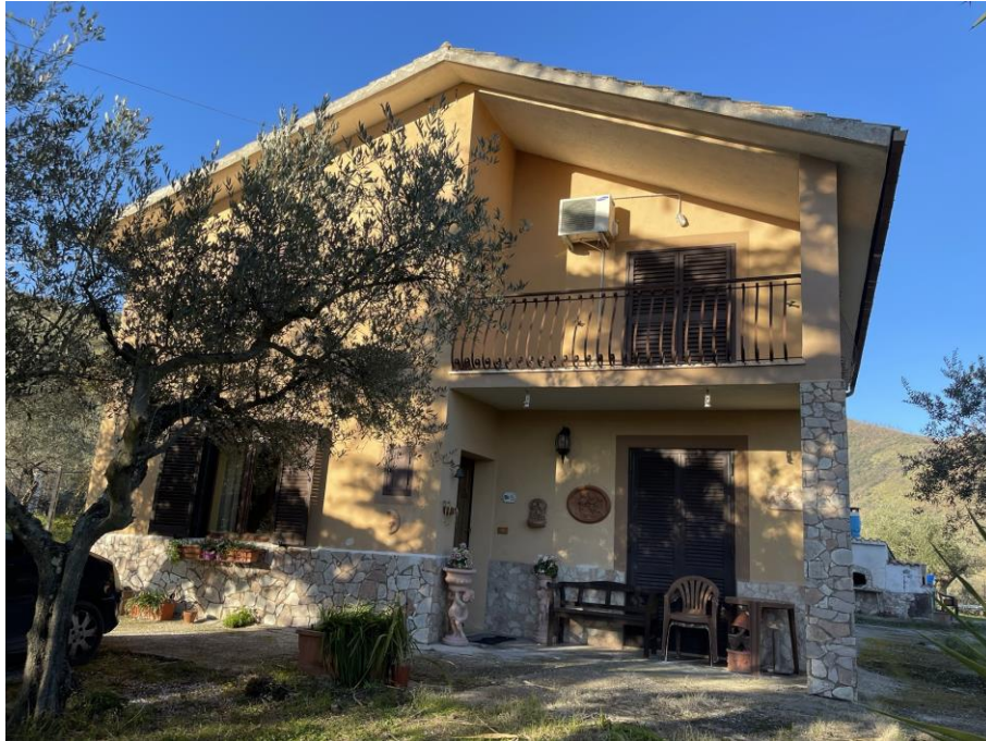
Fotografia n.2 – Il fronte Sud del fabbricato staggito censito al Foglio n.6, Particella n.107.
