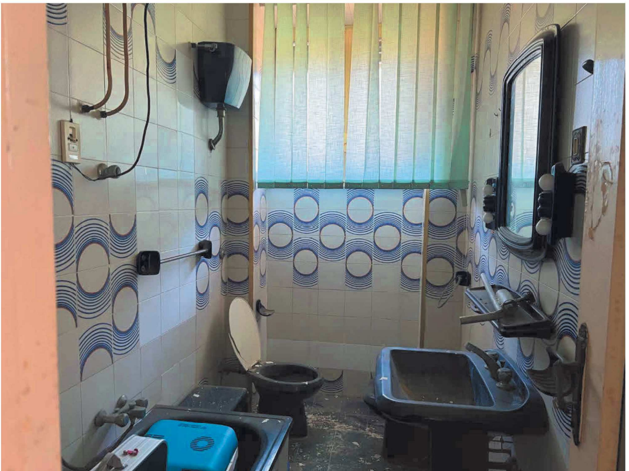
Foto 7 – Vista del bagno
