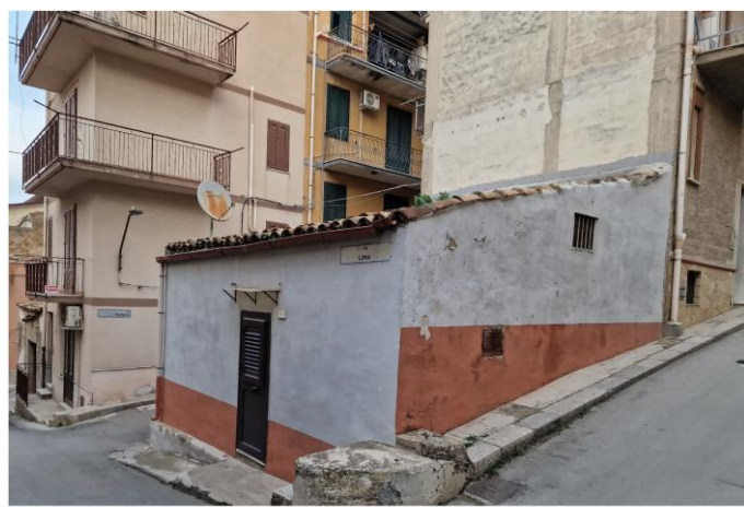
2 | vista da via Cortese
