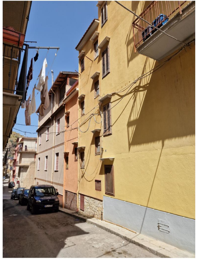
4 | Vista da via Cortese
