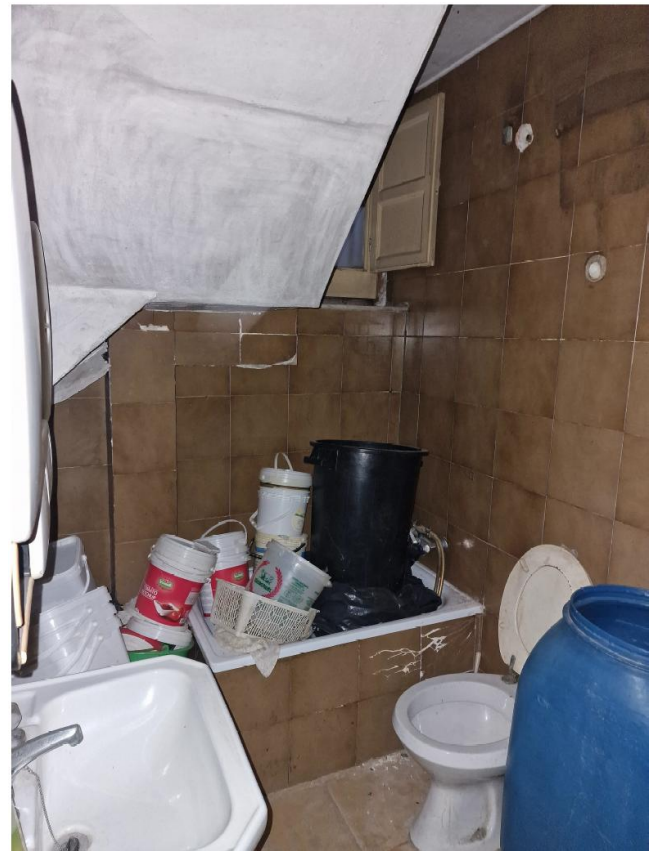
7 | bagno al piano terra
