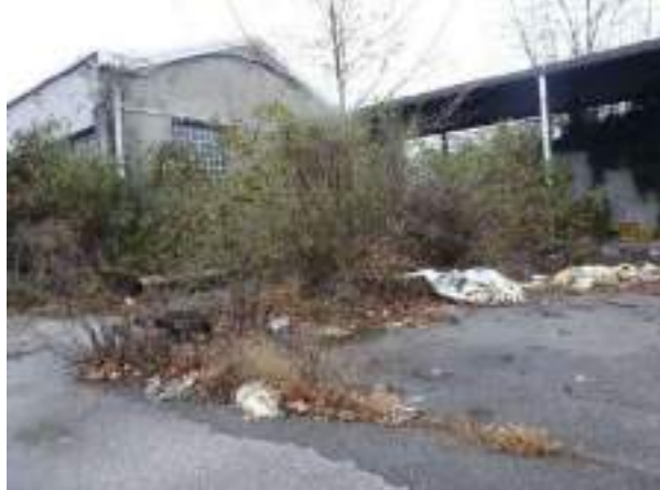
Macchie di idrocarburi: lato est capannone finisaggio
