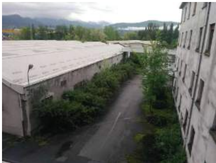
Capannone adibito ai processi di finisaggio
