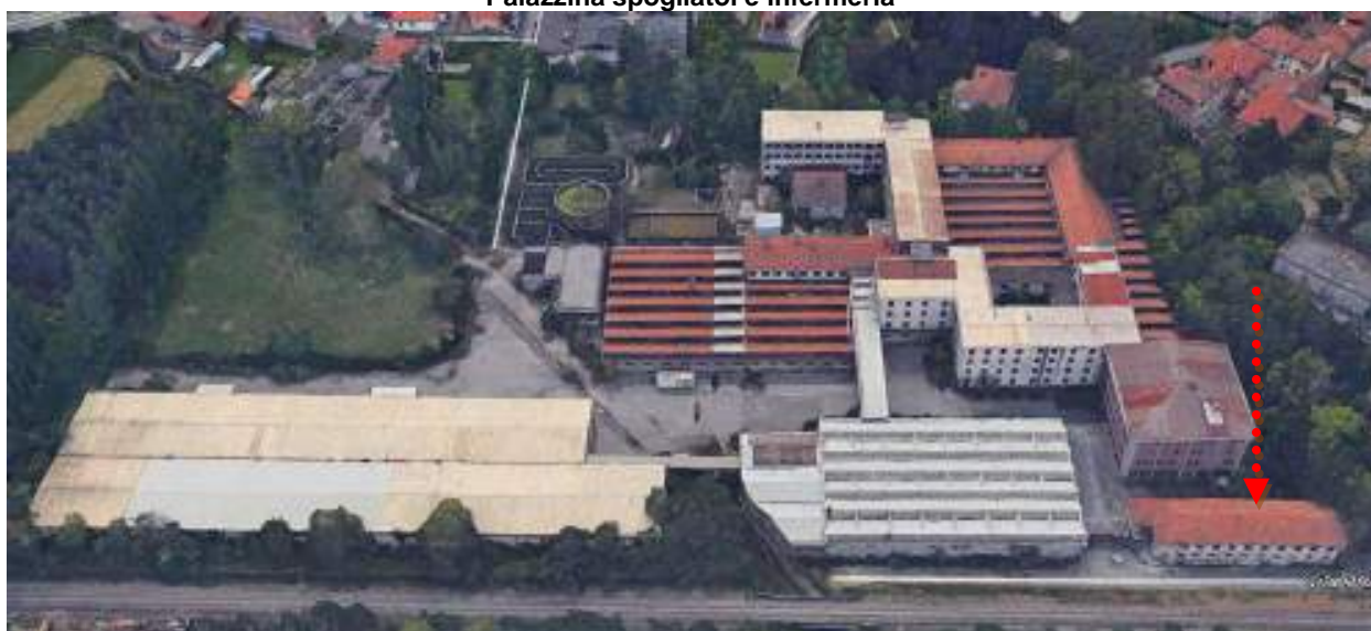
La freccia indica la palazzina spogliatoi
