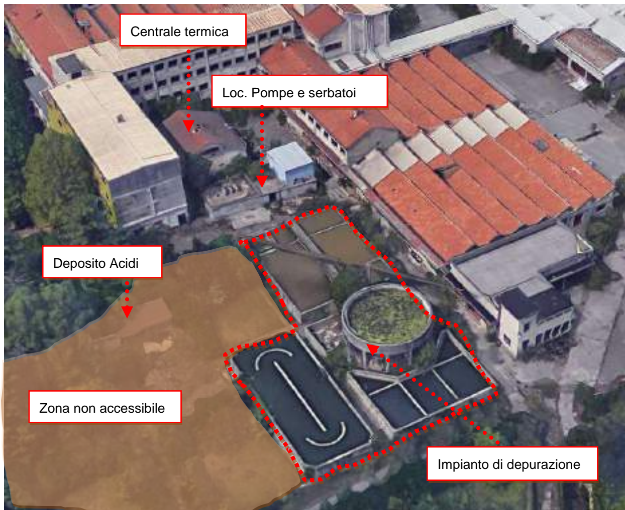
Vista dell'impianto di depurazione
