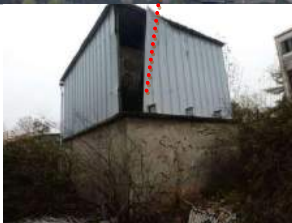
Tettoia con serbatoio
