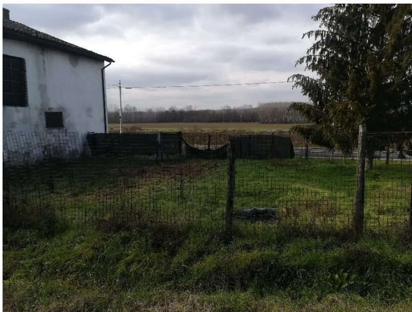
Foto n. 5_Prospetto nord con area pertinenziale
