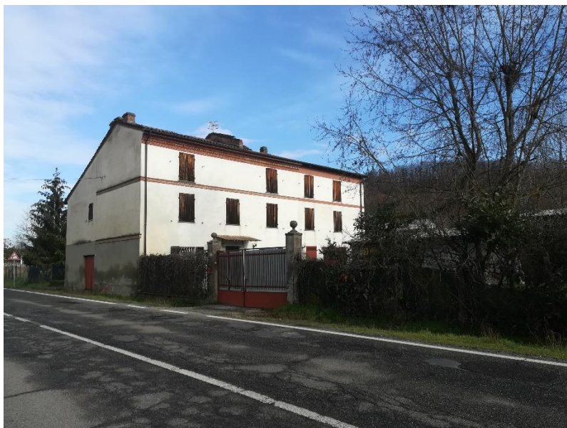
Foto n. 2_ Prospetto sud ed ovest
