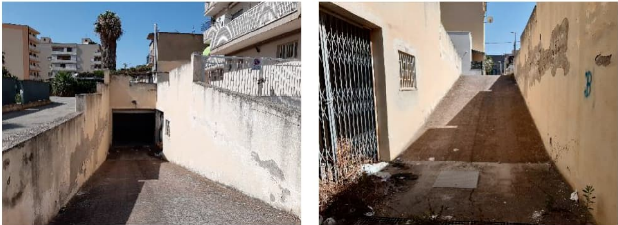
Figura 7: Rampa di accesso carrabile
