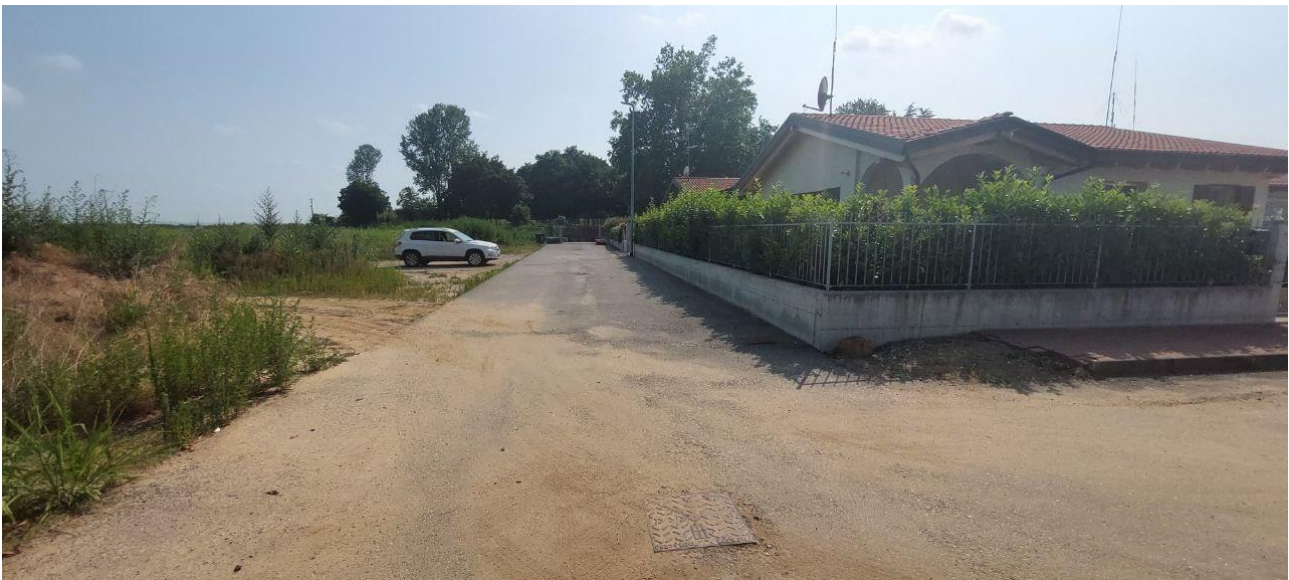
FOTO 4 – Strada realizzata sulla particella 240 – “ LOTTO 1 ”
