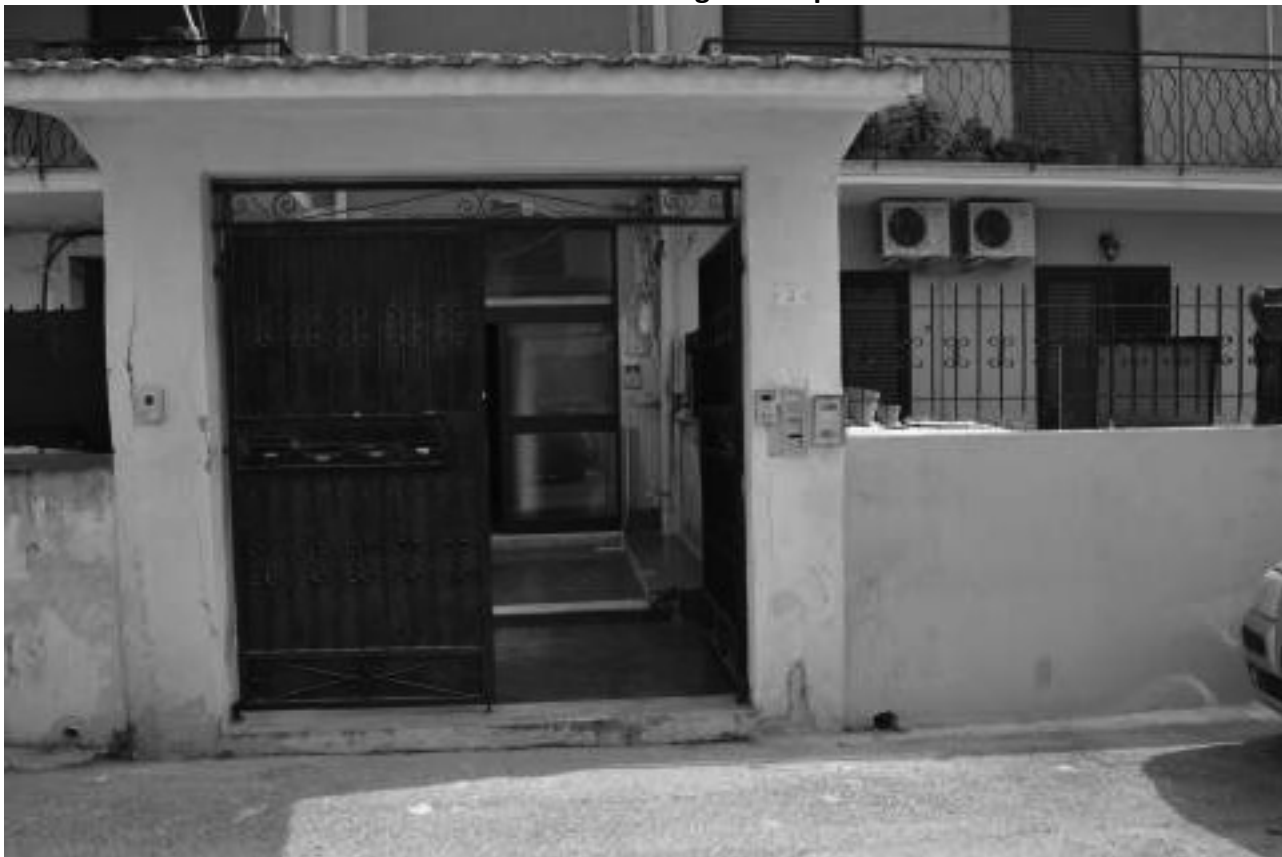
Foto 2 - Immobile - abitazione in Siracusa Via Norvegia n.2 – piano terra.
