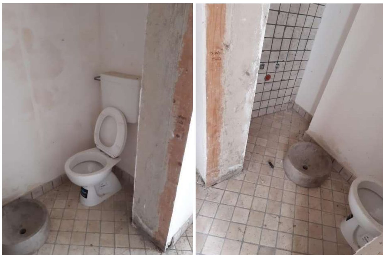
Vista n.17 – W.C. (piano terzo sottostrada) –
