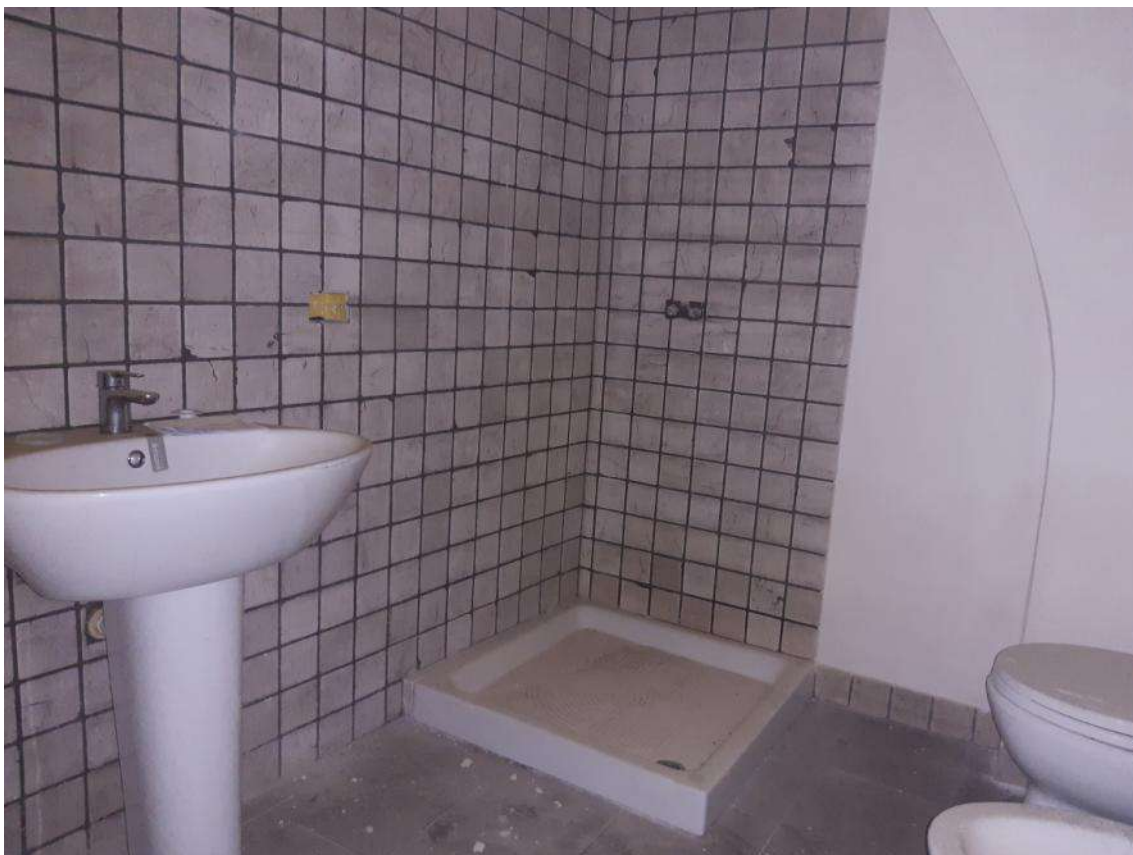
Vista n.13 – Bagno (piano secondo sottostrada) –
