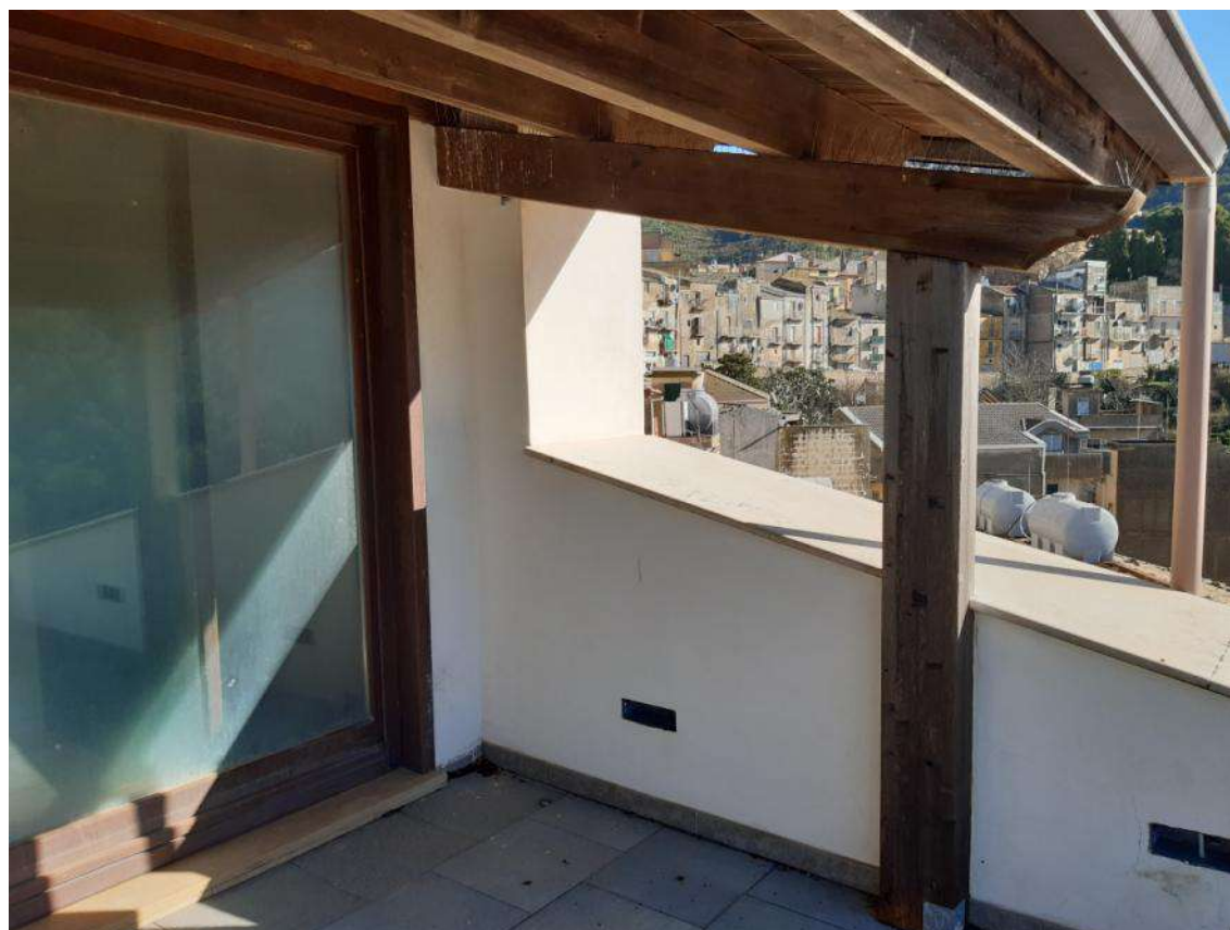
Vista n.18 – Terrazzo con tettoia da demolire (piano 1°) –
