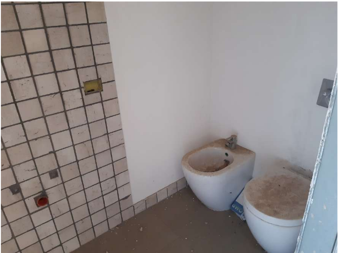
Vista n.8 – W.C. (piano primo) –
