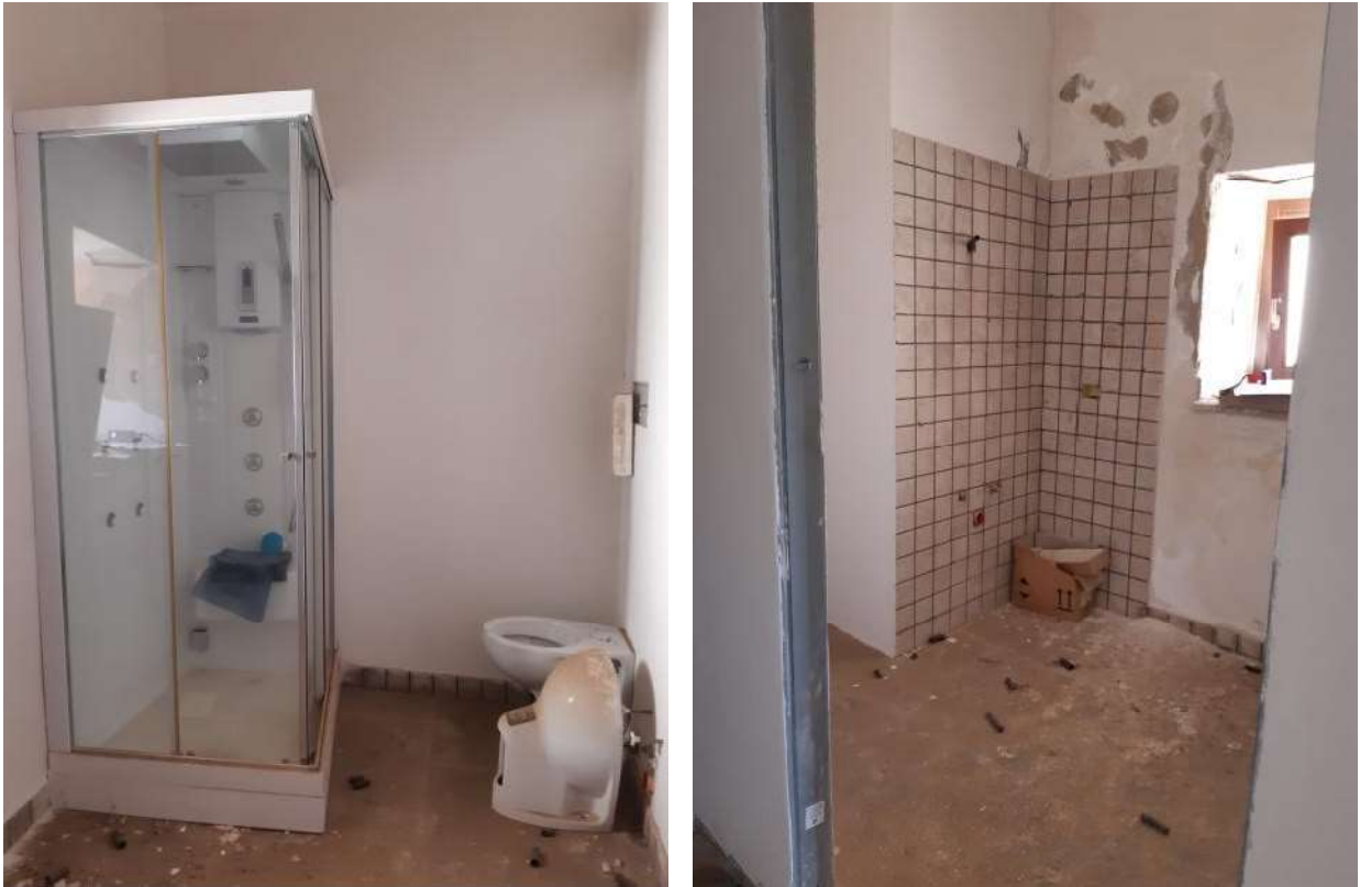
Vista n.11 – Bagno (piano primo sottostrada) –
