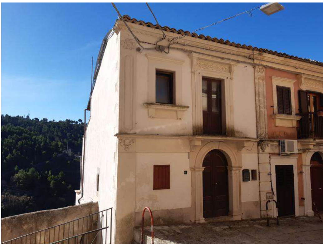
Vista n.2 – Prospetto via S. A. Guastella N.68 –
