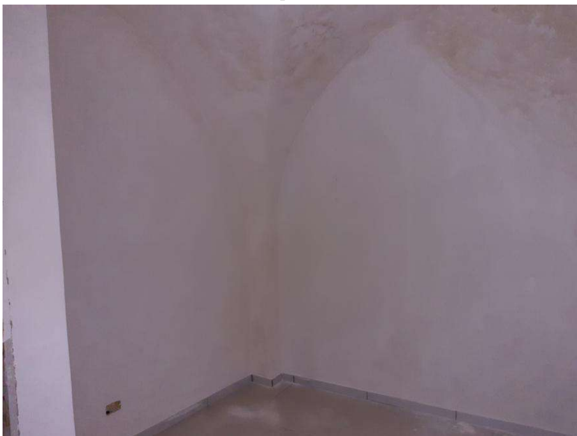
Vista n.14 – Guardaroba (piano secondo sottostrada) –
