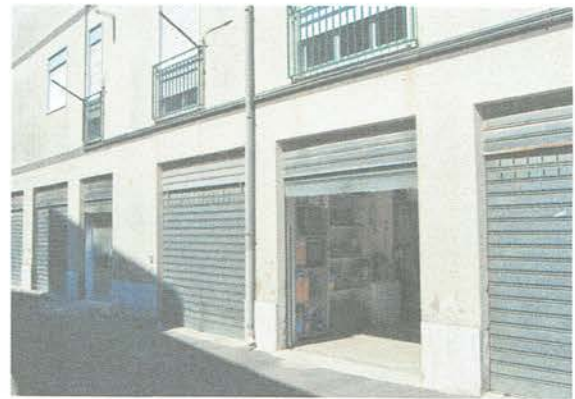
Figura 12: Facciata Box auto
