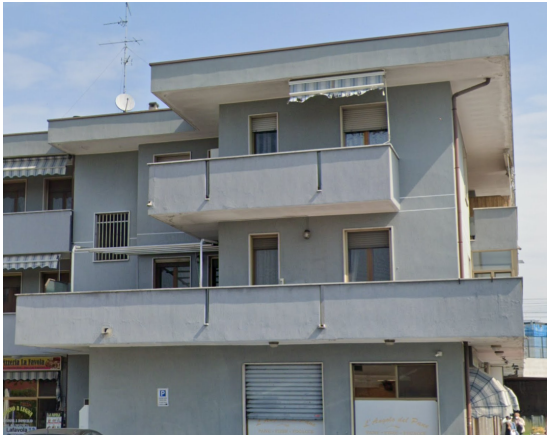
Vista da Via De Gasperi
