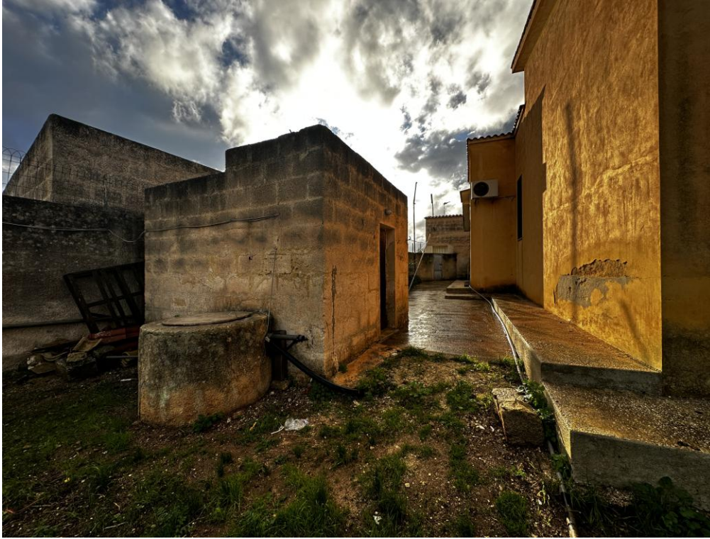
Foto 5 (particolare vano abusivo)
