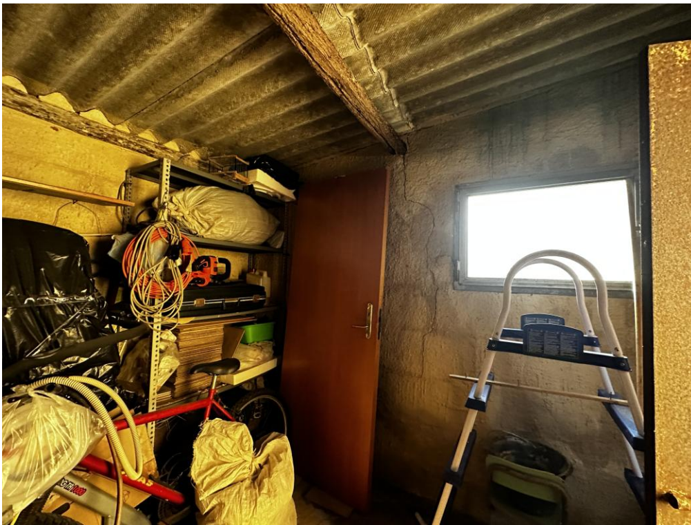
Foto 6 (particolare vano abusivo)
