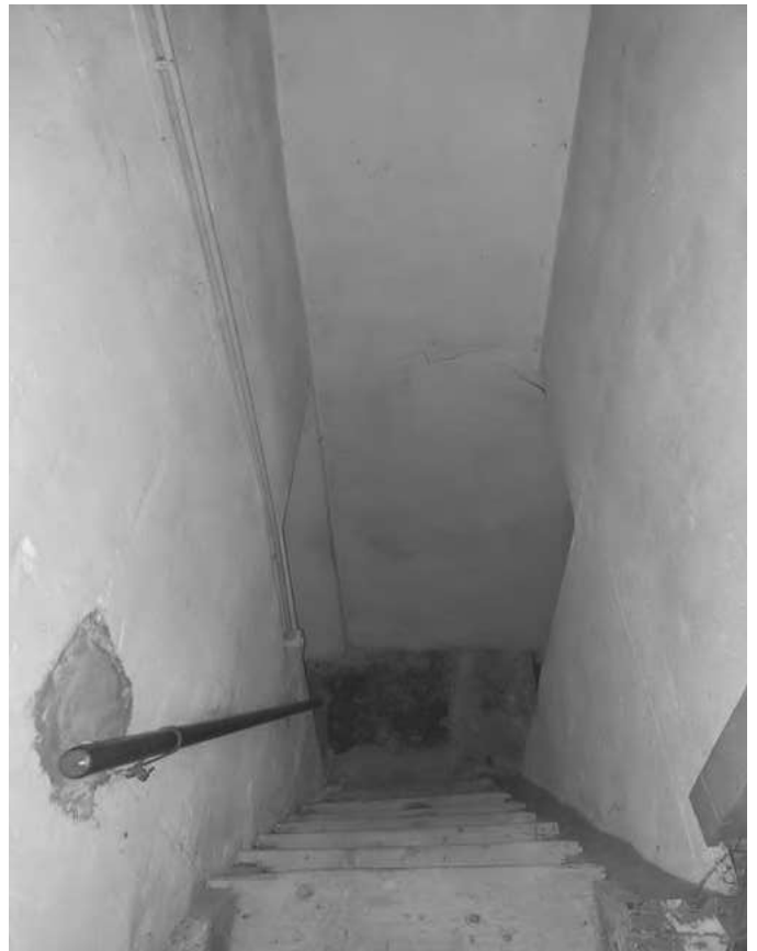
26. vano scala da P.1 a P.T
