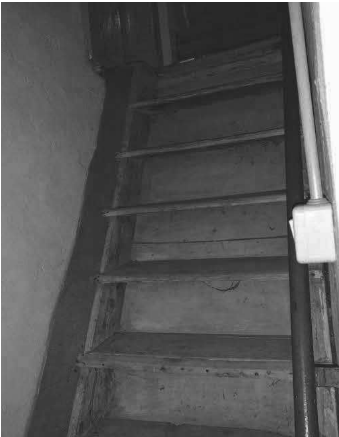
25. vano scala da P.T a P.1
