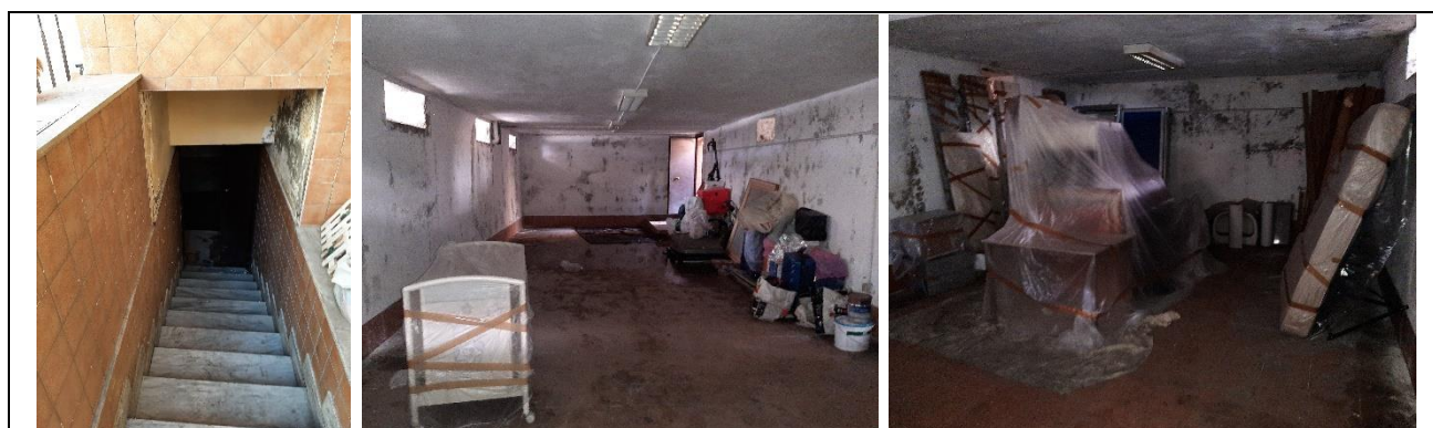
Foto 1/2/3 – Vista dell'ingresso e interno sub.3
