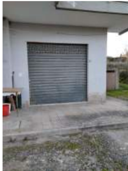
Foto n. 11 – Uscita esterna magazzino
