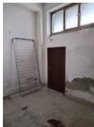
Foto n. 5 – Particolare porta murata
