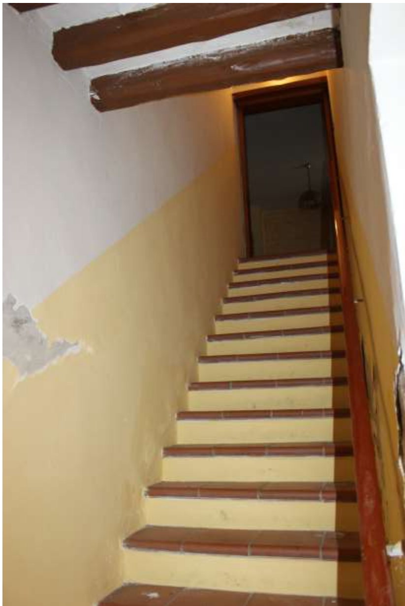
Scala di accesso al piano primo
