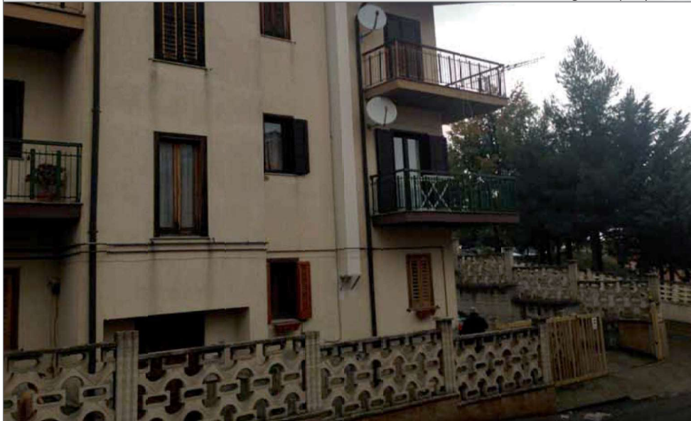
PERIZIA DI STIMA R.G.E. N°201/12 - PROSPETTO ESTERNO - VISTA ESTERNA PORTONE INGRESSO ALLOGGI - Edificio residenziale in via Pennetti n°2 in Comune di Stigliano (MT)
