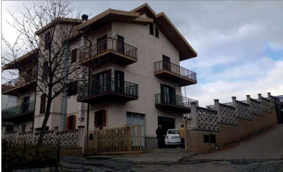
PERIZIA DI STIMA R.G.E. N°201/12 - PROSPETTO ESTERNO - VISTA ESTERNA SU VIA PENNETTI - Edificio residenziale in via Pennetti n°2 in Comune di Stigliano (MT)
