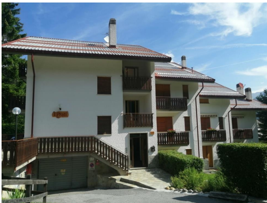
Foto 1 – Facciata esterna del fabbricato su via Campo Principe 43.
