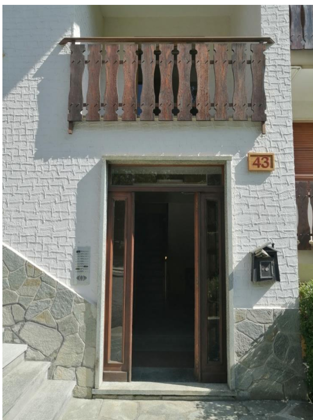
Foto 2 – Portoncino di ingresso esterno.
