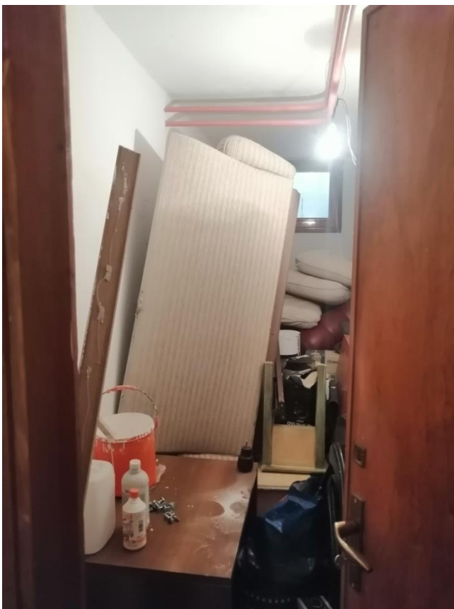
Foto 12 – Deposito unità sub. 21
