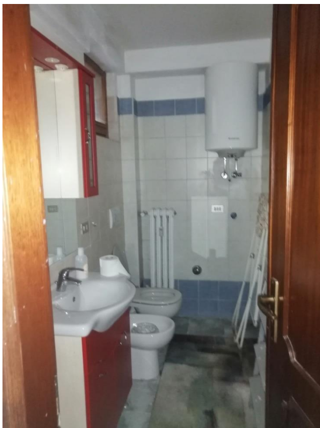
Foto 14 – W.C. unità sub. 22
