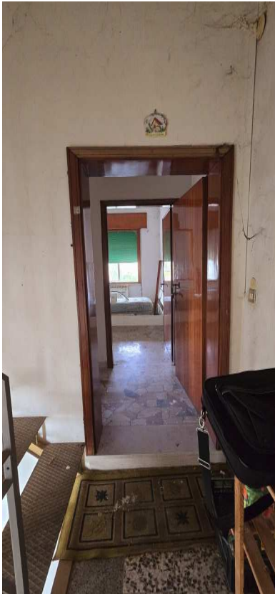
Vista porta ingresso
