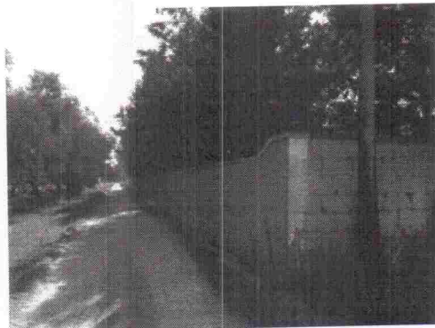
Vista del muro di cinta su via Caccari
