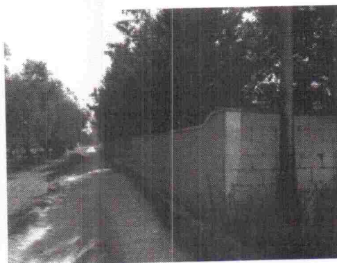
Vista del muro di cinta su via Caccari
