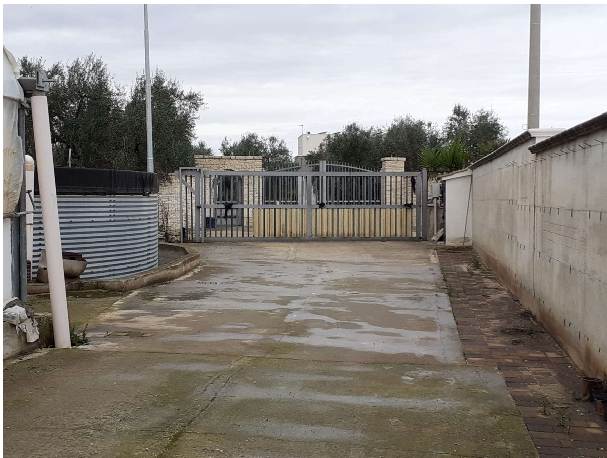
VISTA SECONDO ACCESSO DA STRADA COMUNALE CENTOVIGNE
