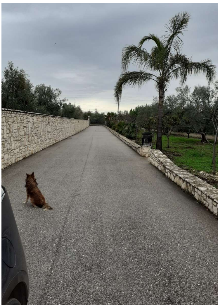
VIALE DI ACCESSO (CONTROCAMPO)
