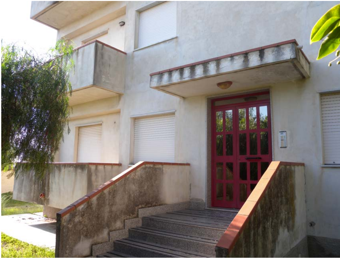
Foto n. 2 Vista portone ingresso scala condominiale
