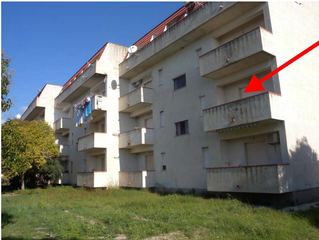
Foto n. 3 Vista lato posteriore
