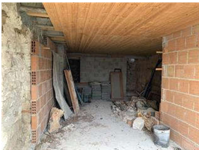
Vista da esterno
