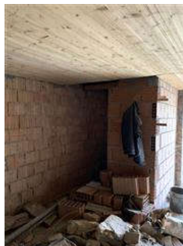
Vista vano costruito
