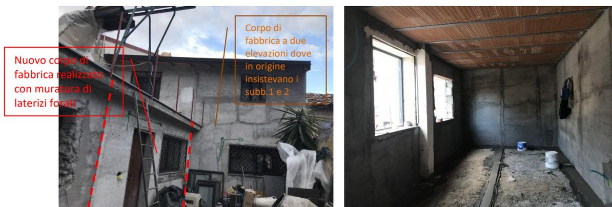
A Sx vista delle porzioni oggetto di ampliamento ed a Dx vista del nuovo solaio costituito da lame e tavelloni
