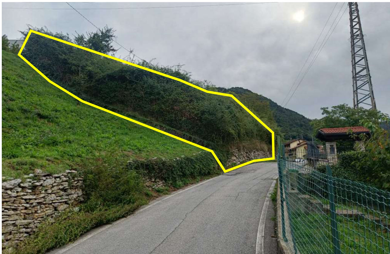
VISTA SUD TERRENO DA PARTE BASSA DI VIA SANTA LUCIA
