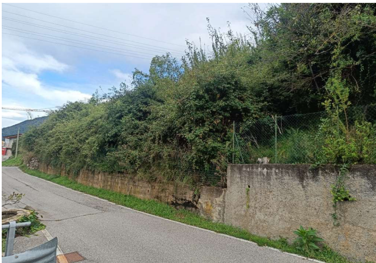
VISTA NORD TERRENO DA PARTE BASSA DI VIA SANTA LUCIA
