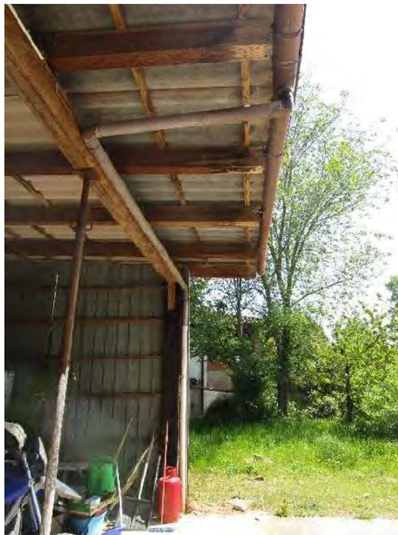
56. Dettaglio della puntellatura della trave imbarcata nella campata di destra.
