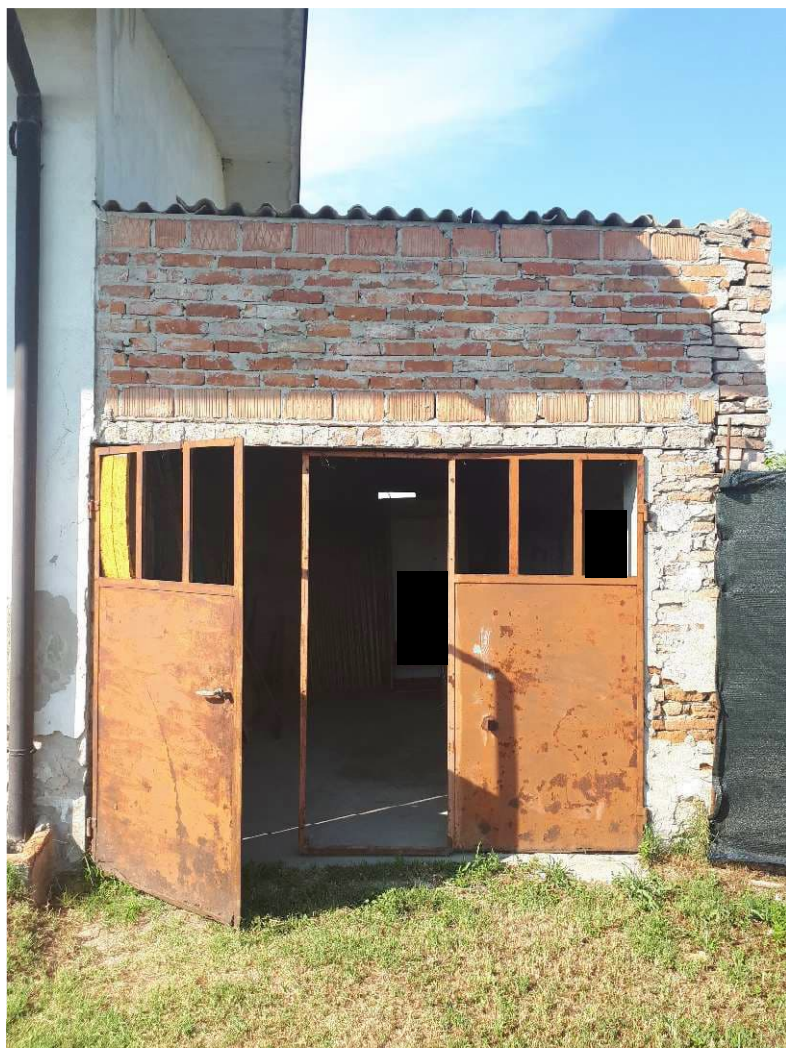
piccolo annesso dell'edificio da demolire
