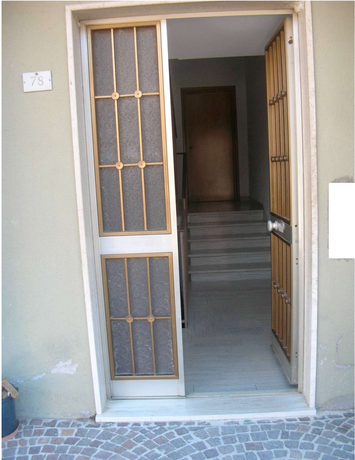
Particolare dell'ingresso comune, a monte
