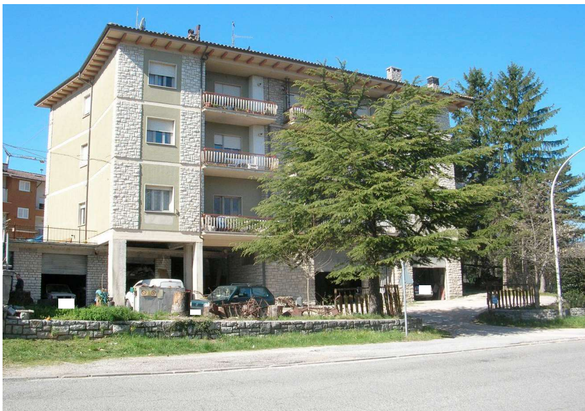
Particolare d'insieme dell'intero edificio da Via Goffredo Mameli (a valle)
