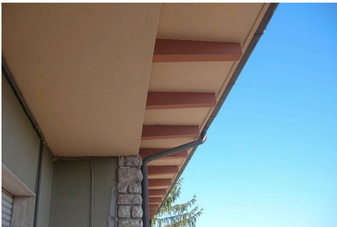
Particolare della linea di gronda (in corrispondenza del terrazzo della cucina)
