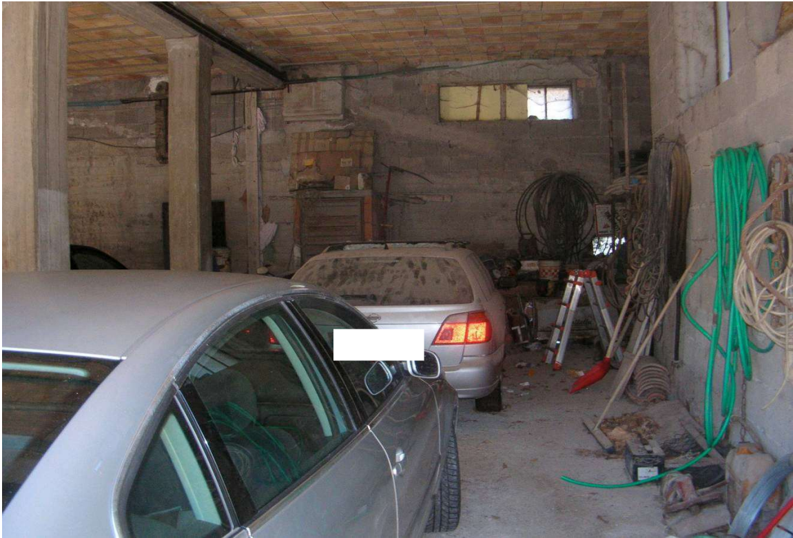
Particolare del garage comune al P. Seminterrato (comune solo con altro appartamento del sub. 5)
