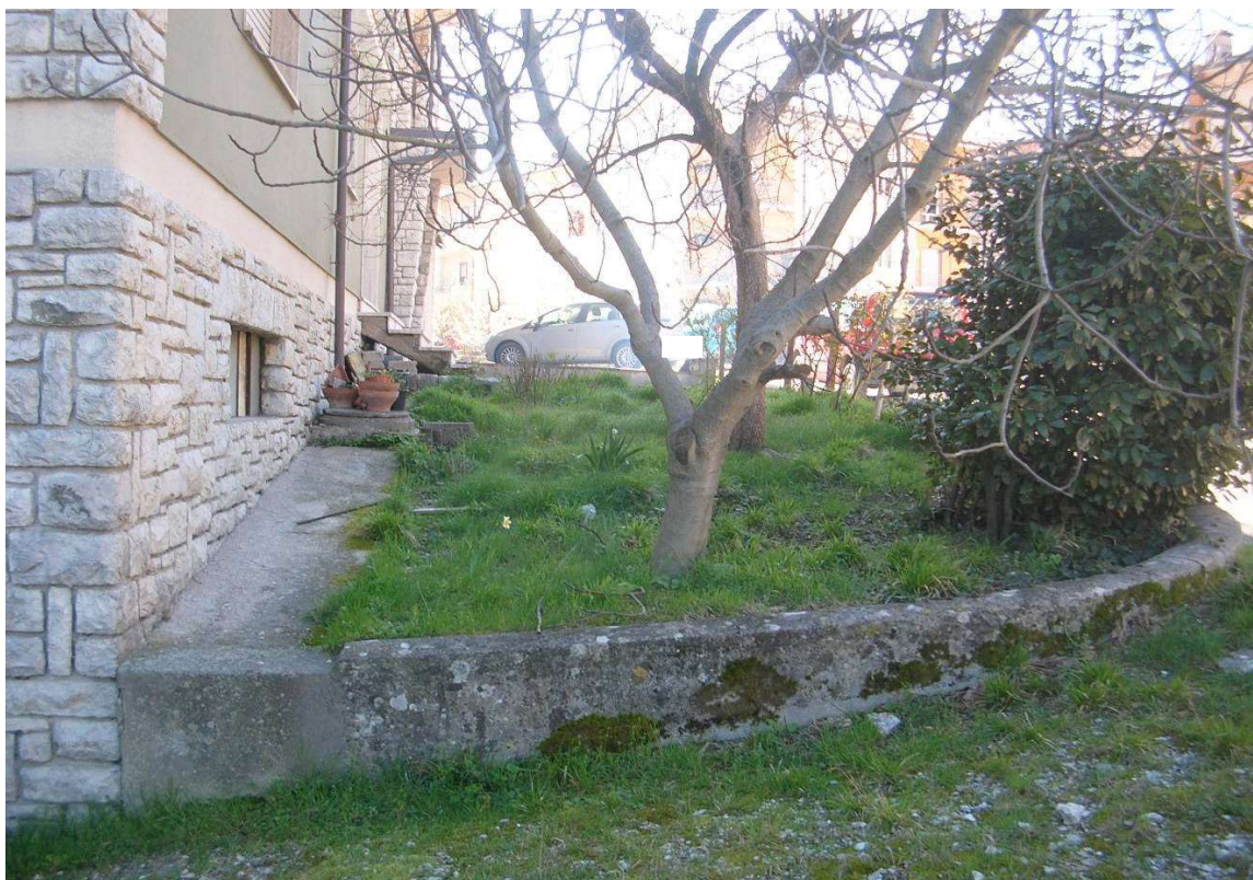
Particolare dello scoperto comune verso monte (su Via Cairoli)
