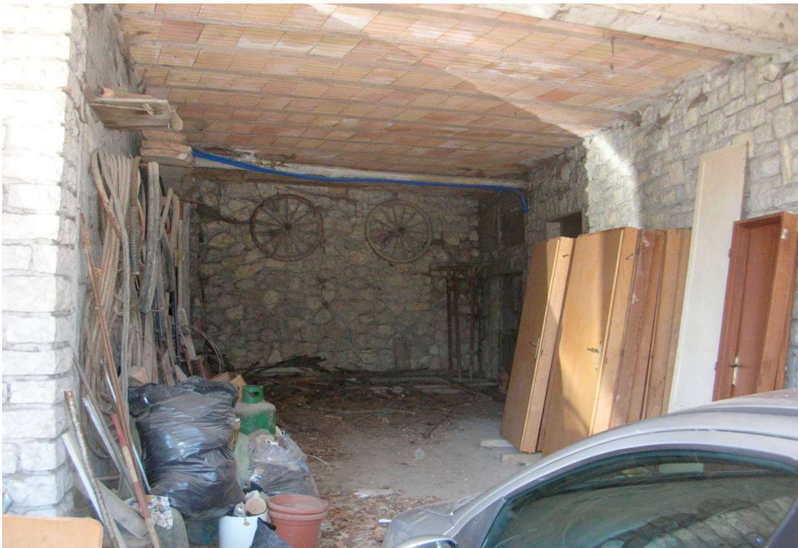
Particolare del tunnel comune a più unità, aperto, al P. Seminterrato
