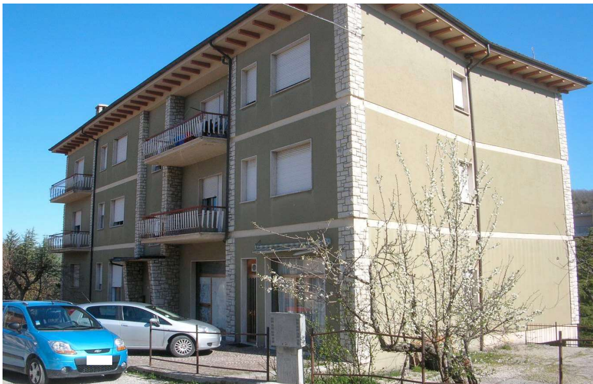
Particolare d'insieme da Via Cairoli
