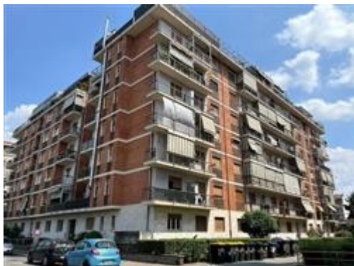
VISTA ESTERNA STABILE
