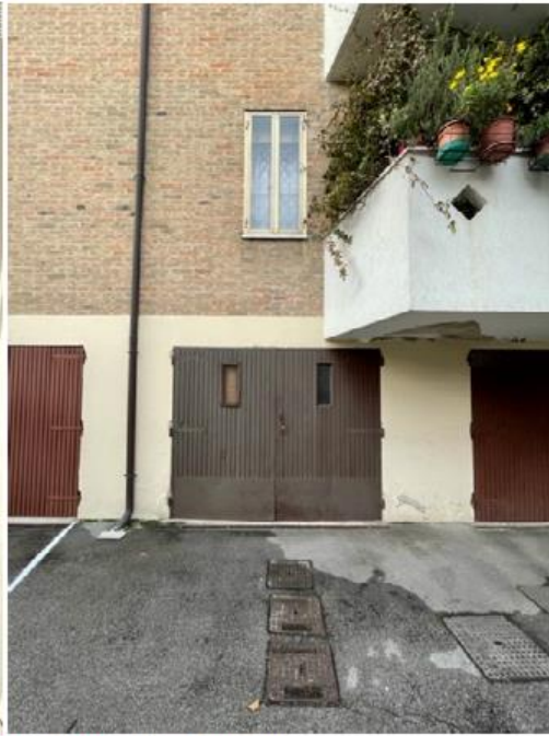
vista del basculante del garage
