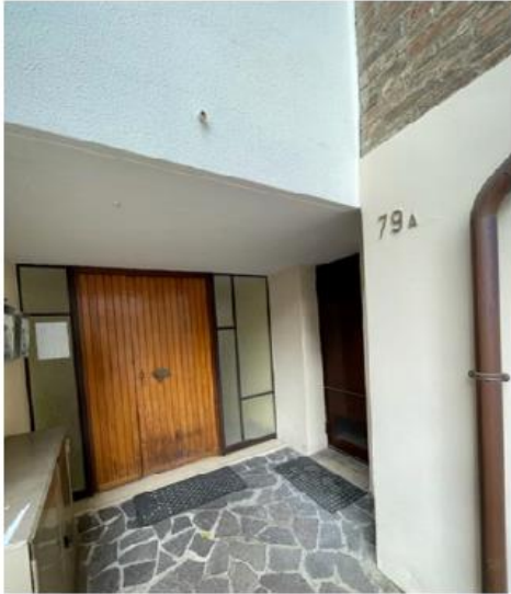
vista del portone di accesso al vano scala comune
