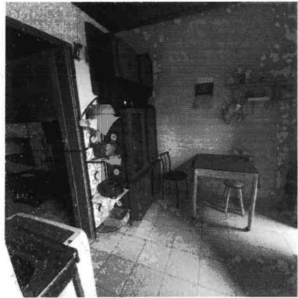
Tramezzatura interna a realizzazione di due vani
