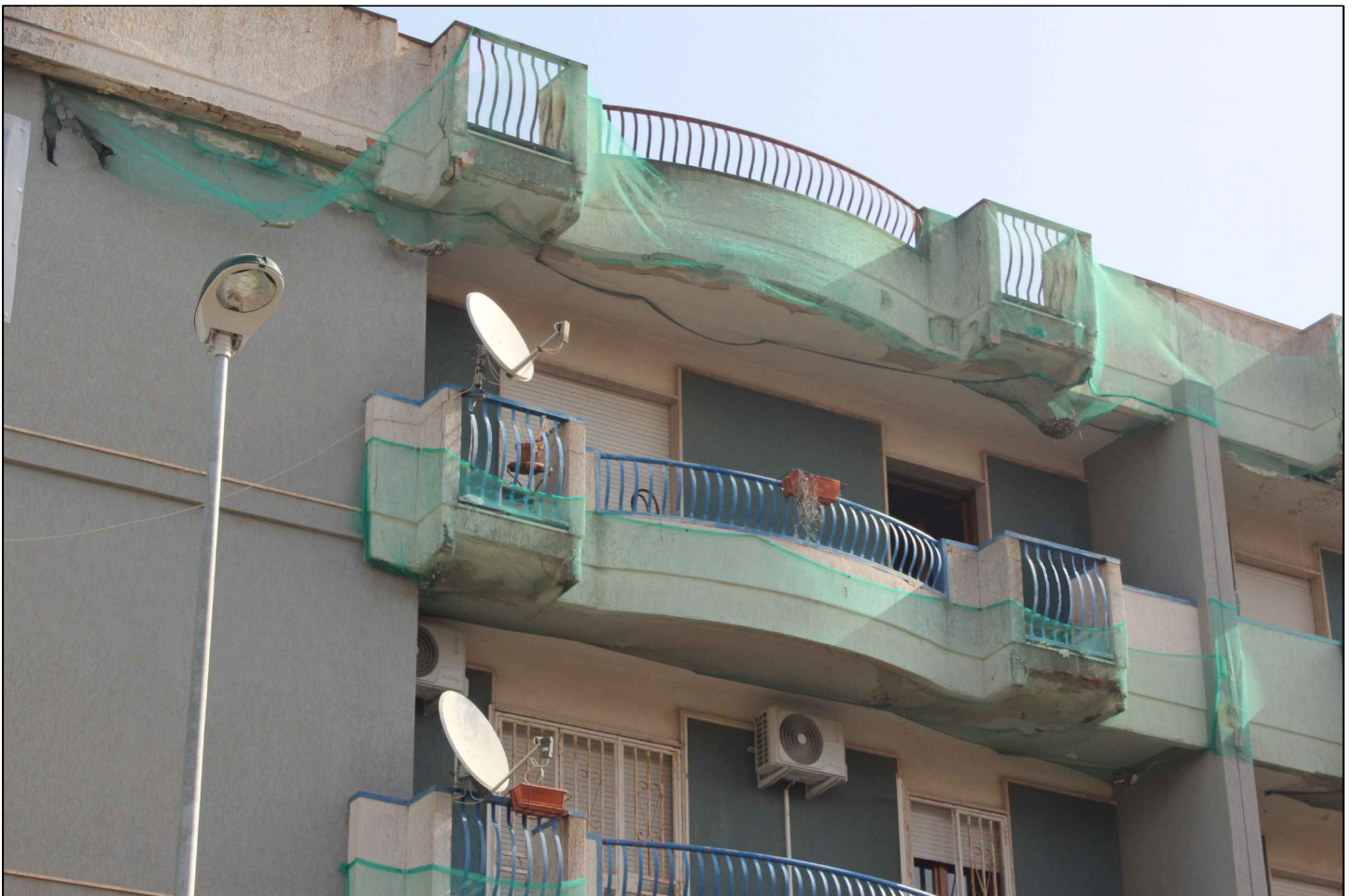
N.4 Vista da Viale Filippo Turati
