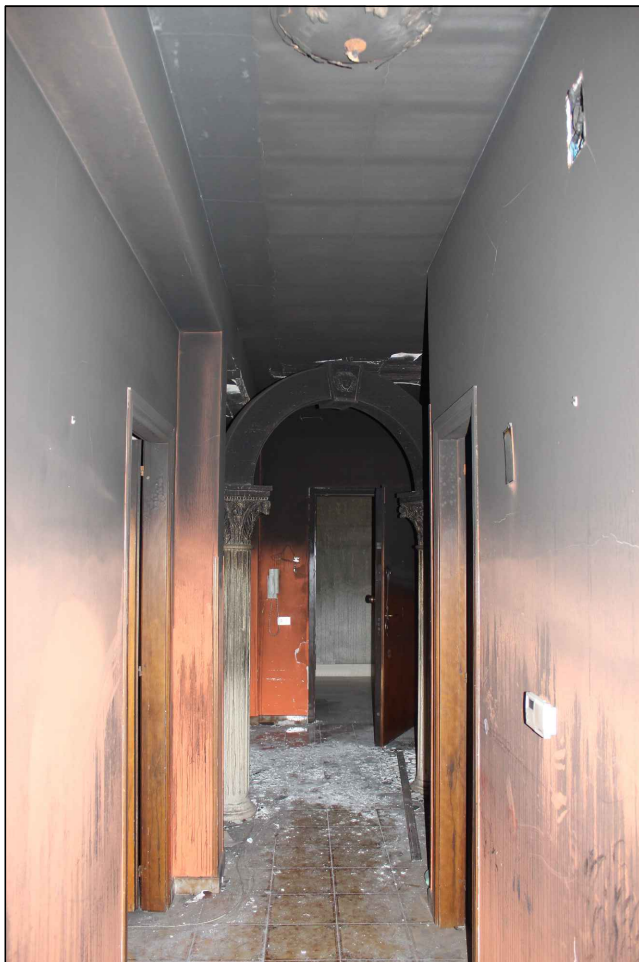
N.16 Corridoio (con vista ingresso)
