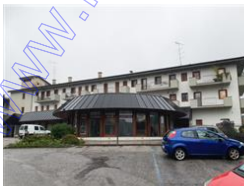
vista del fronte principale del "Residence Boschetti"
