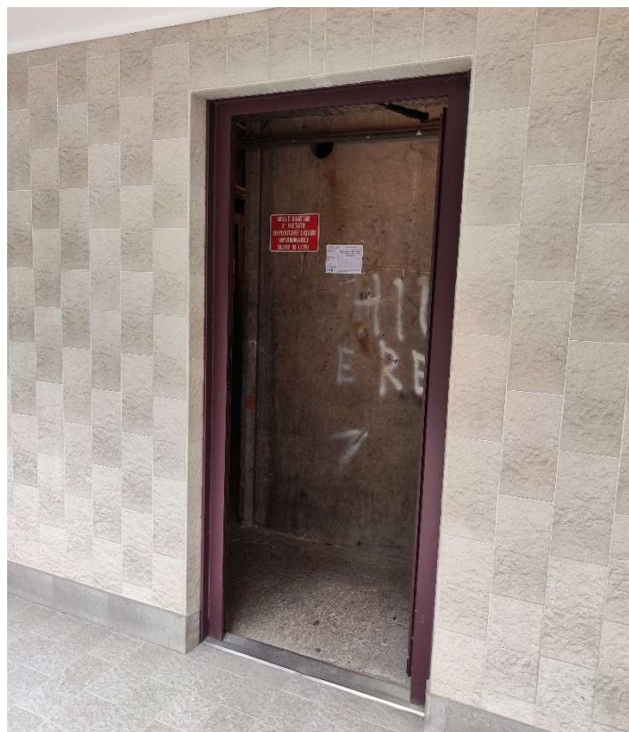
Foto n. 14 – Accesso ai locali cantina
