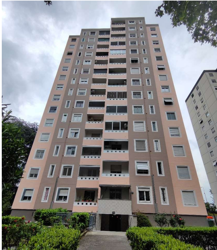
Foto n. 1 – Veduta frontale dell'edificio
