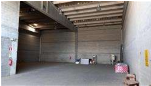
Particolare interno zona lavorazione
