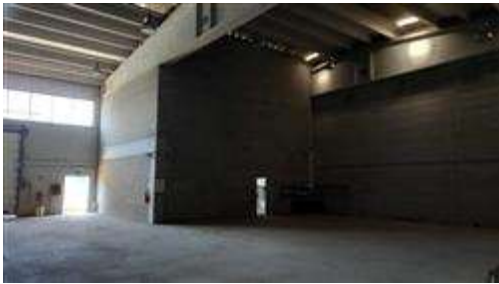
Particolare interno zona lavorazione
