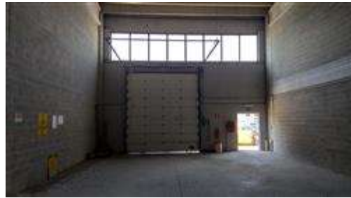
Particolare interno zona lavorazione
