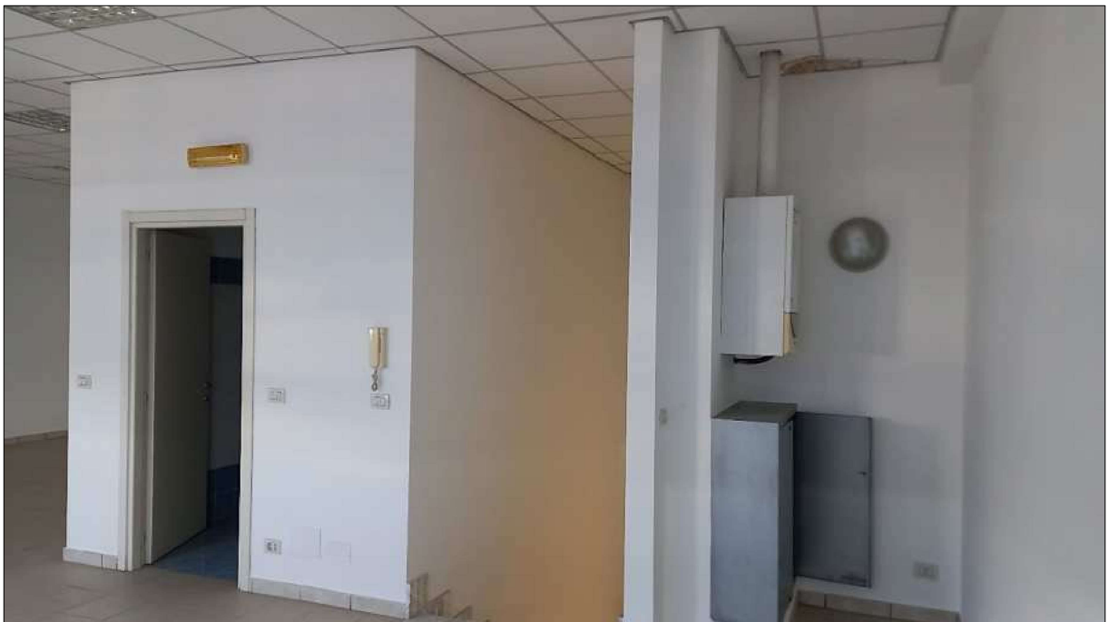
Foto n. 22 – Particolare interno uffici a p.1°
