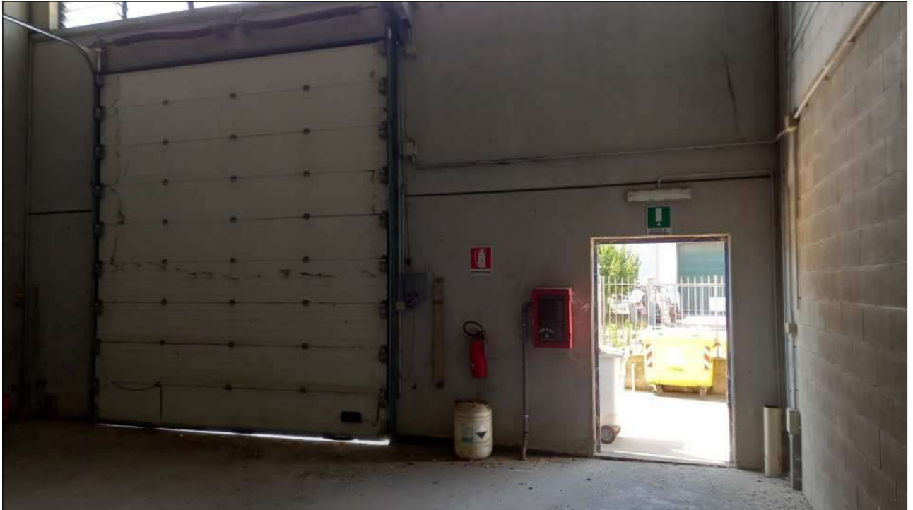
Foto n. 9 – Particolare interno con accesso carrabile e pedonale
