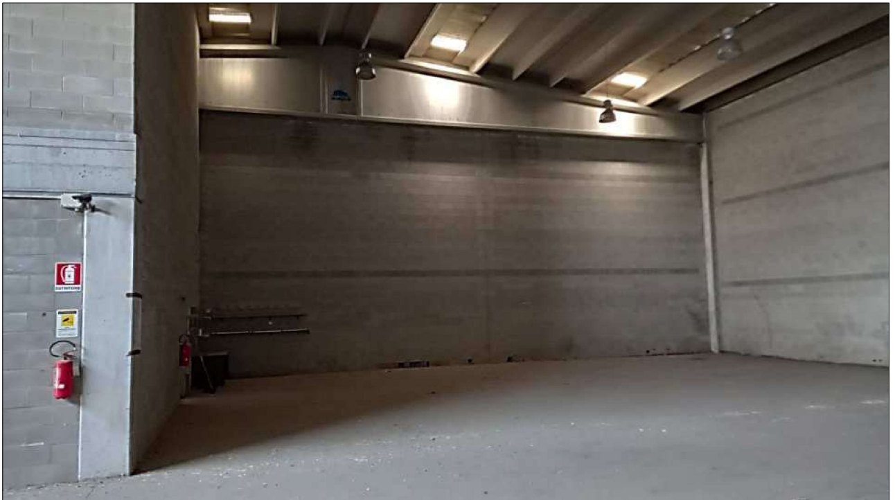
Foto n. 13 – Particolare interno zona lavorazione/deposito
