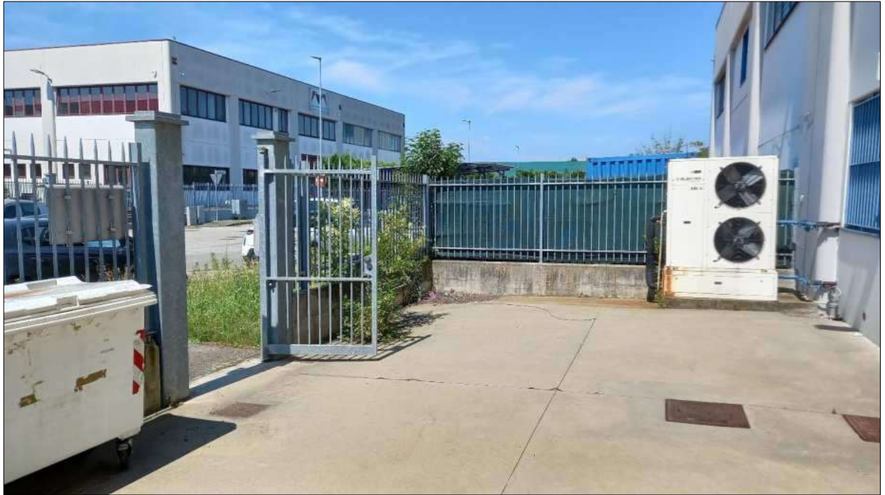
Foto n. 29 – Particolare piazzale esterno
