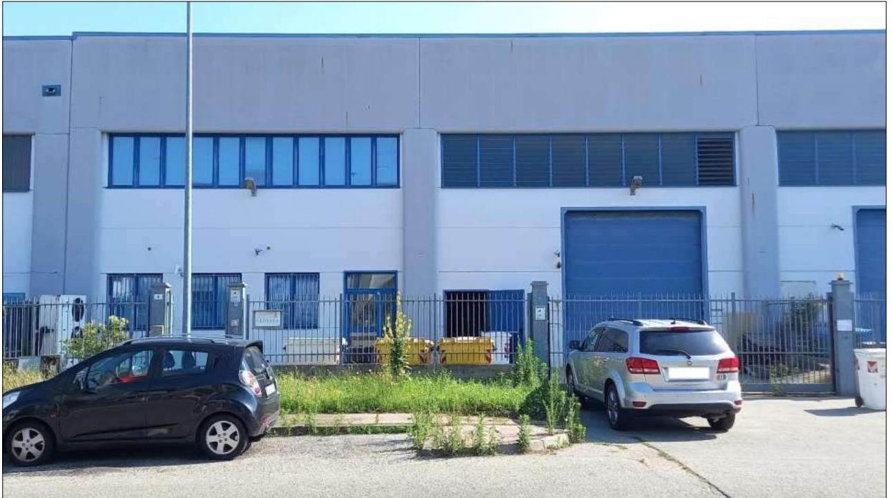
Foto n. 3 – Prospetto sud con ingresso da Via dell'Ottone n. 4
