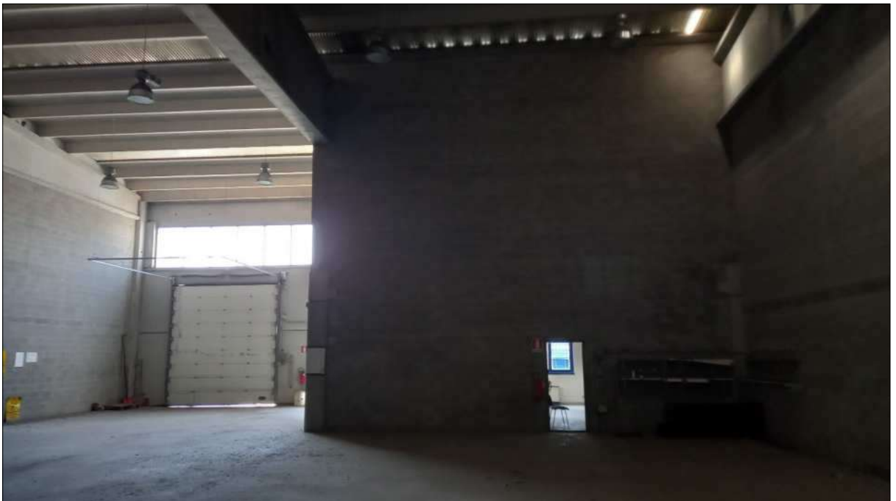
Foto n. 12 – Particolare interno con sagoma blocco uffici
