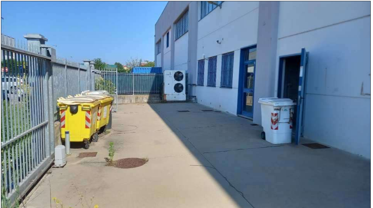
Foto n. 8 – Particolare piazzale d'ingresso
