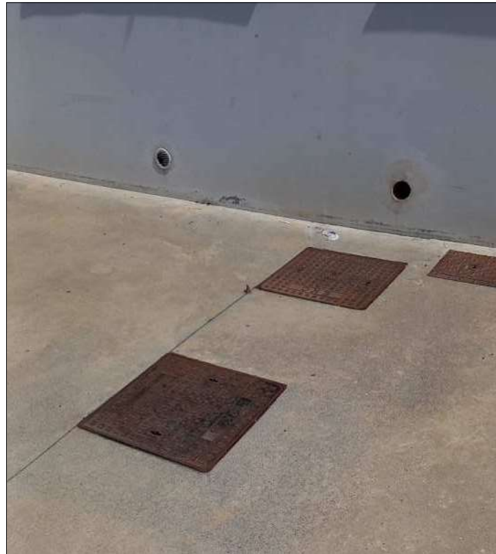
Foto n. 30 – Particolare piazzale esterno
