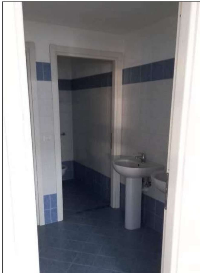
Foto n. 21 – Particolare interno servizi in uffici a p.t.
