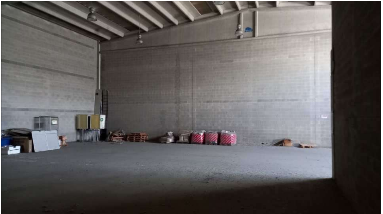
Foto n. 16 – Particolare interno zona lavorazione/deposito
