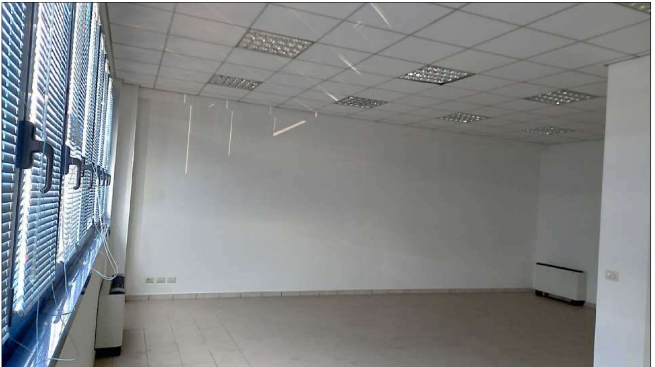
Foto n. 24 – Particolare interno uffici a p.1°
