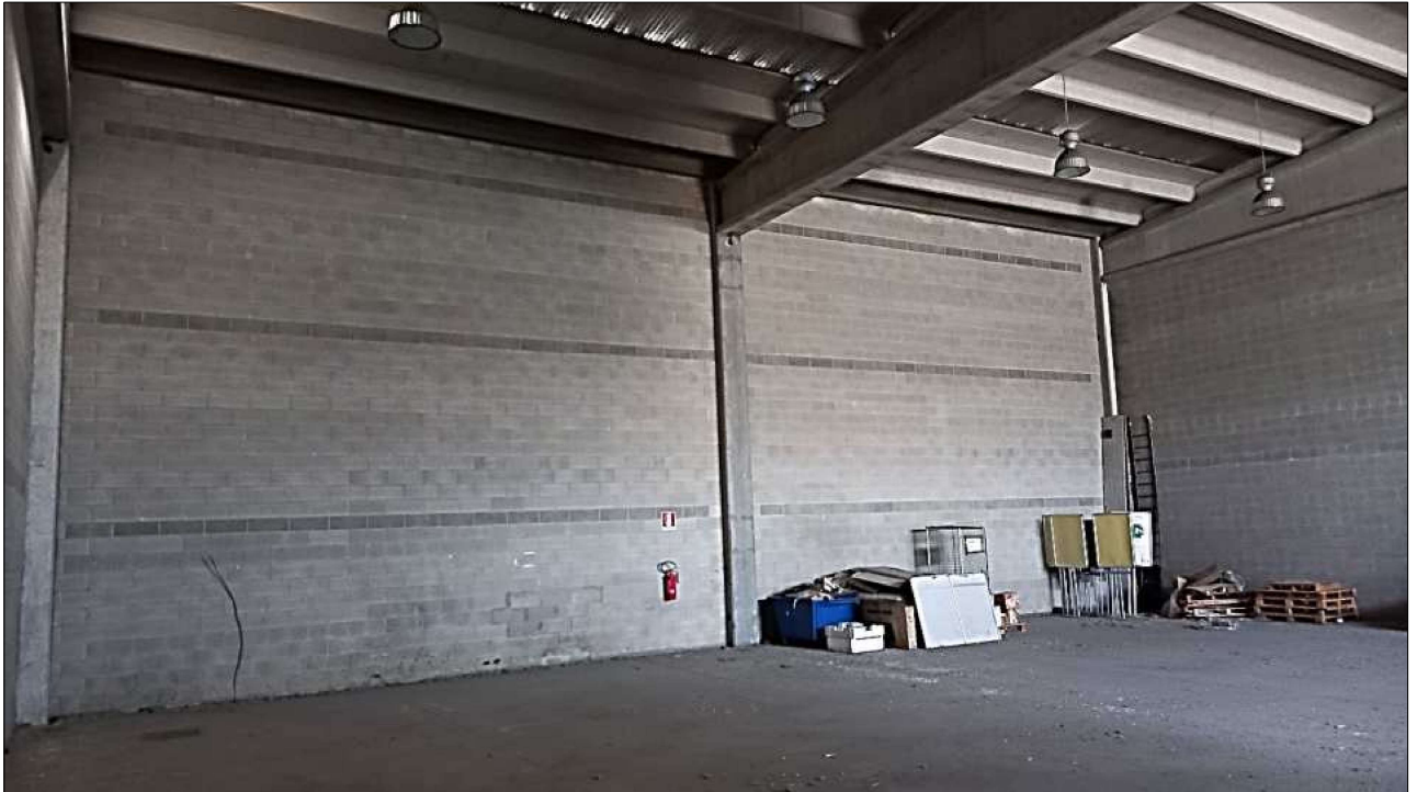
Foto n. 15 – Particolare interno zona lavorazione/deposito
