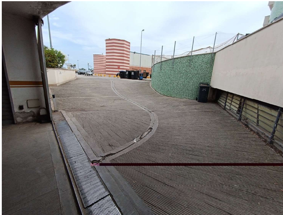
Vista della rampa di accesso all'autorimessa
