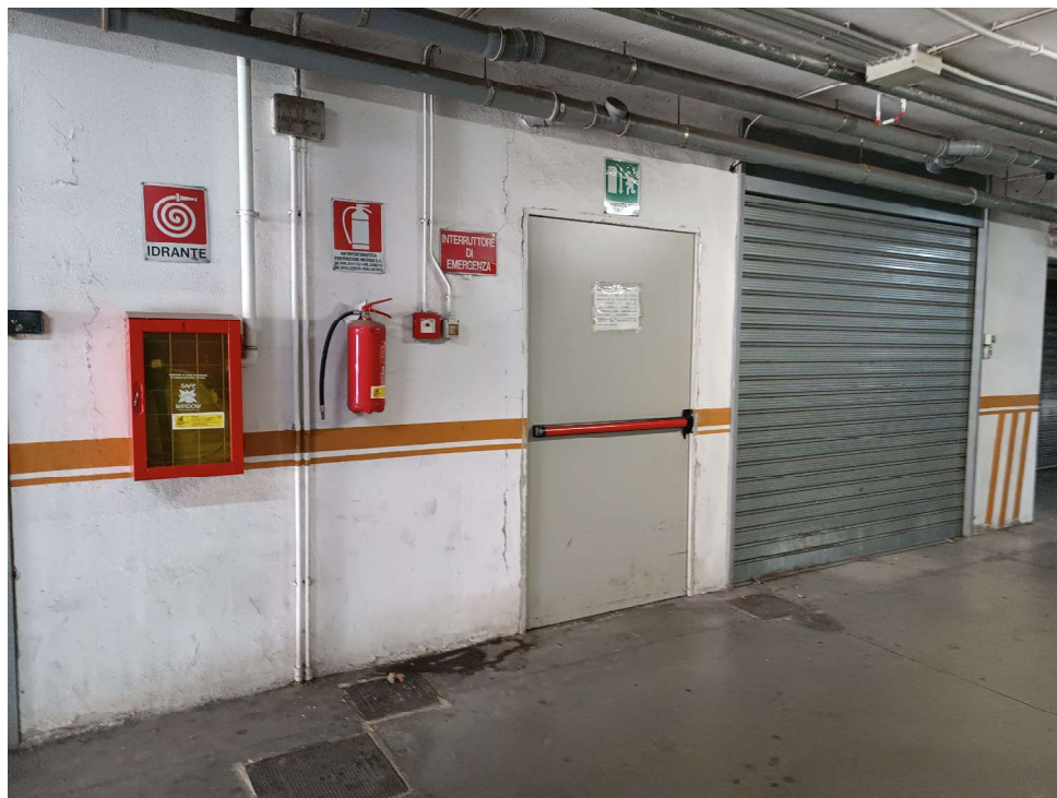
Vista della porta di accesso al vano scala I
