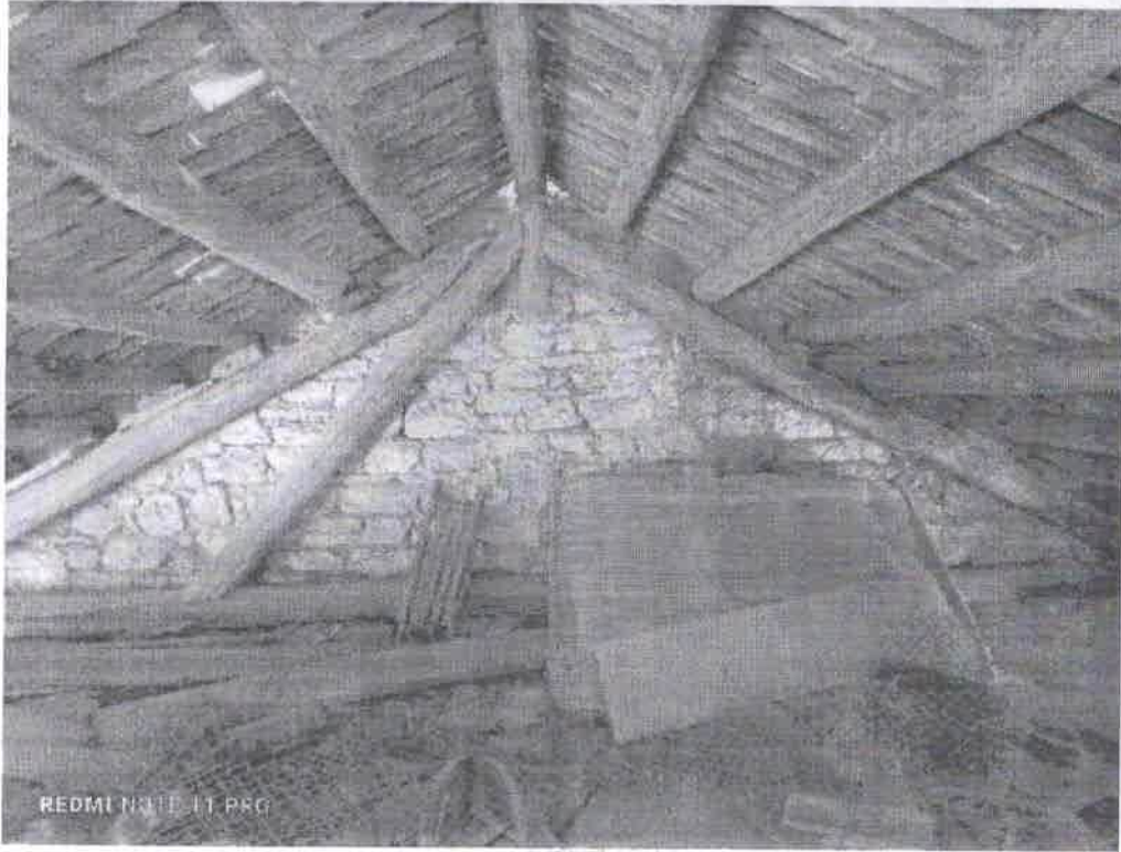
SOFFITTA – TIMPANO OVEST
