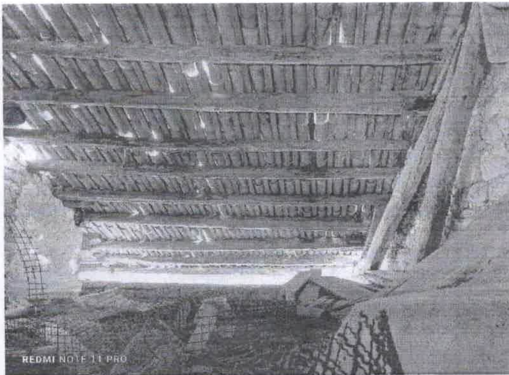
SOFFITTA – VANO OVEST
