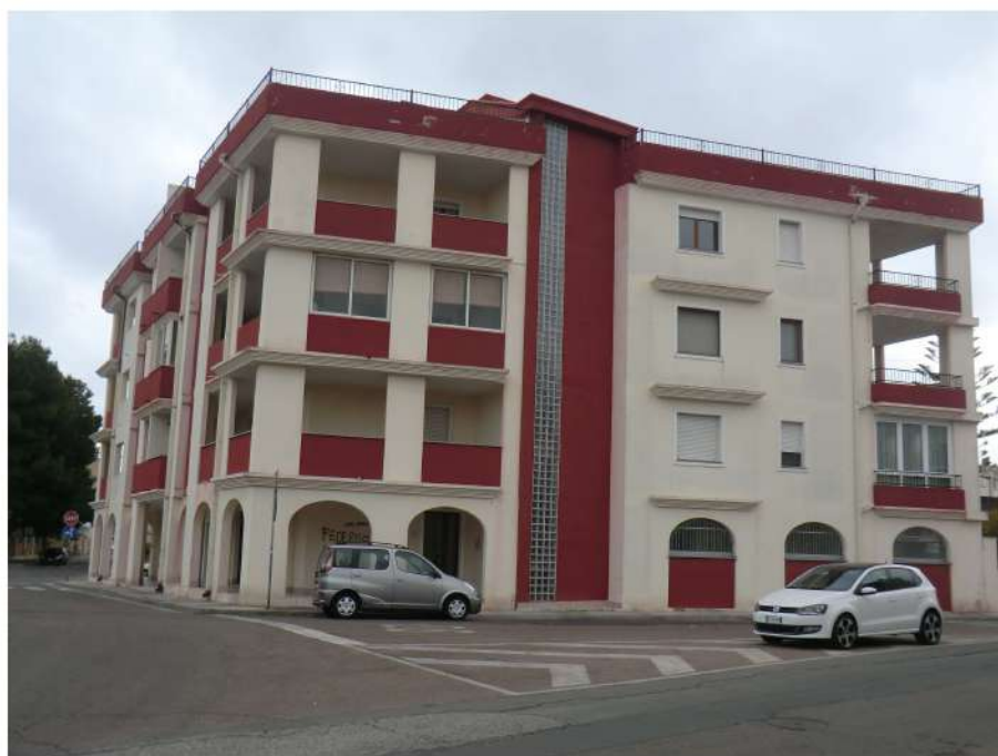
Foto n.2. Quartu S. Elena. Prospetto lato via A. Stradivari. Ingresso scala (piano interrato cantine sub. 31,35,36,37 oggetto di pignoramento).
