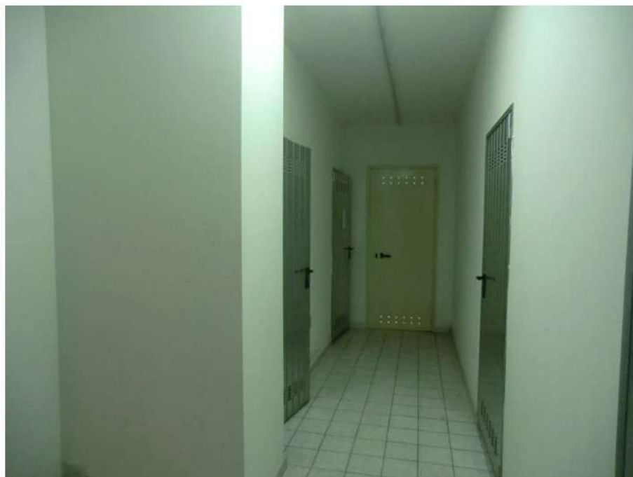
Foto n.8.Via Antonio Stradivari n.1. Disimpegno cantine. E' visibile la porta di separazione delle ultime due cantine.
