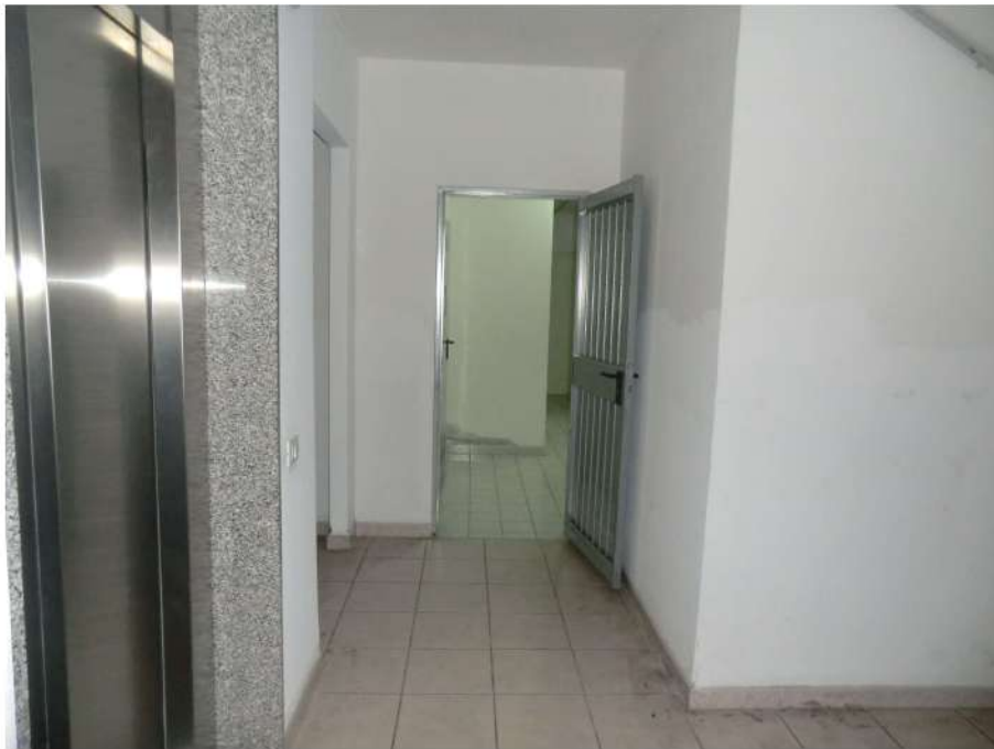
Foto n.6. Via Antonio Stradivari n.1. Porta di accesso alla zona cantine.
