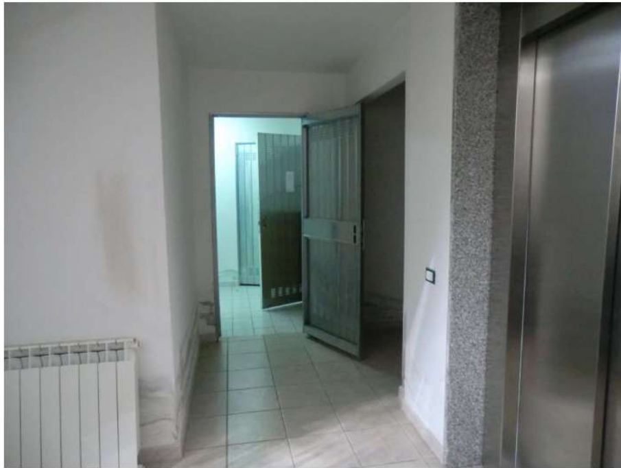
Foto n.15.Via Is Arenas n.14. Porta di accesso alla zona cantine.
