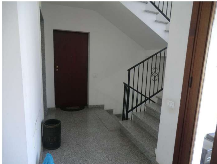
Foto n.14. Via Is Arenas n.14. Scala condominiale. Rampa di accesso al piano interrato.
