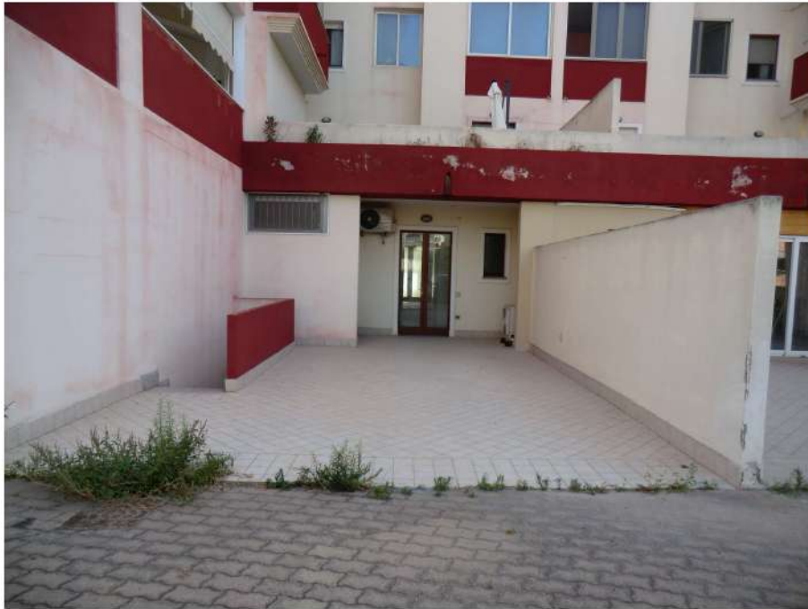
Foto n.29.Via Is Arenas n.16C . Cortile. Area urbana sub.67.
