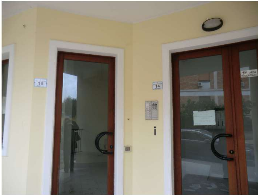
Foto n.13. Via Is Arenas n.14. Ingresso condominiale (accesso alle cantine sub.21,22,23,24).
