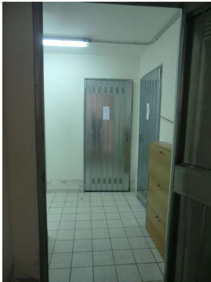
Foto n.16. Via Is Arenas n.14. Disimpegno cantine.
