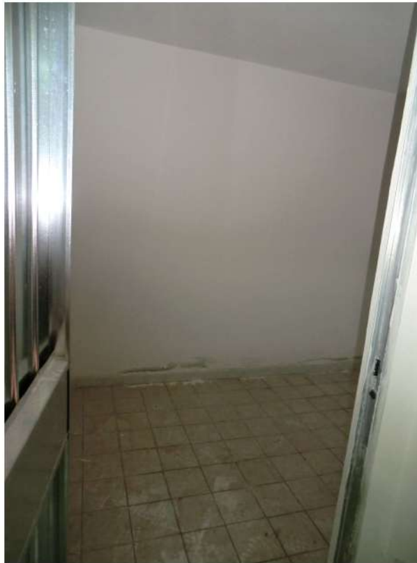
Foto n.19.Via Is Arenas n.14. Cantina sub.23. Sono visibili tracce di umidità di risalita.
