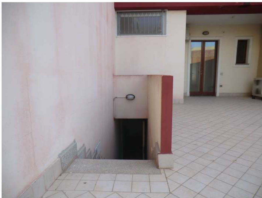
Foto n.30.Via Is Arenas n.16C.Cortile.Area urbana sub.67.Scala di accesso al piano interrato.
