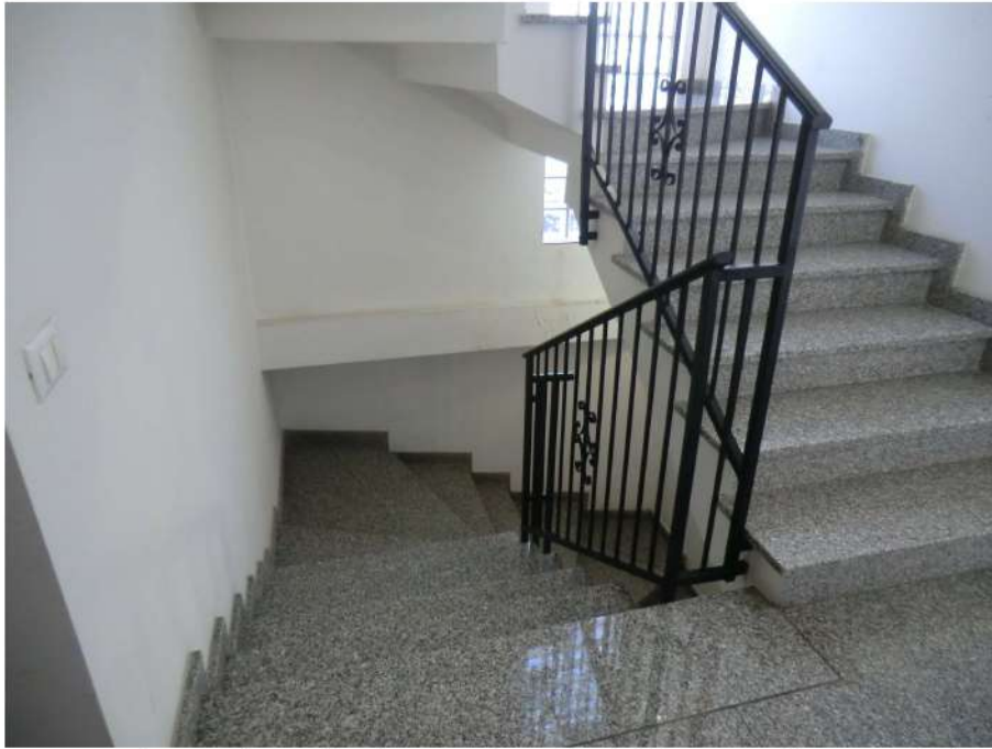
Foto n.5. Via Antonio Stradivari n.1. Scala condominiale. Rampa di accesso al piano interrato.
