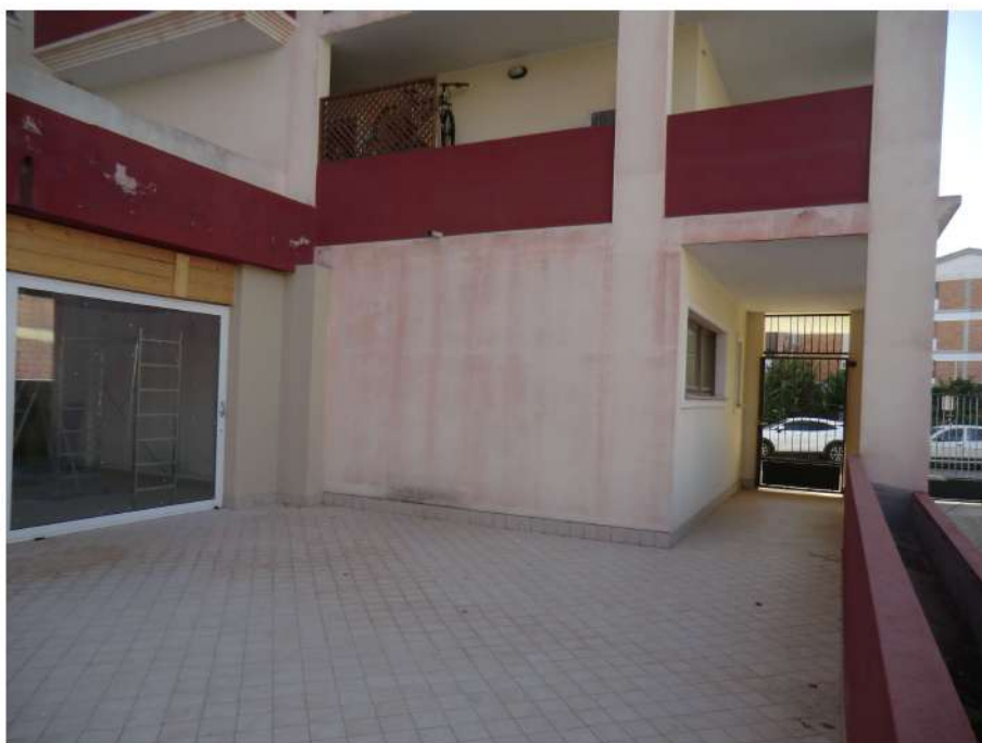
Foto n.28.Via Is Arenas n.16C . Cortile. Area urbana sub.66. E' visibile il cancello pedonale.
