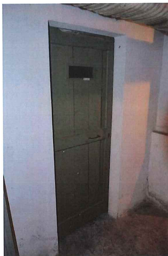
24. porta di accesso cantina
