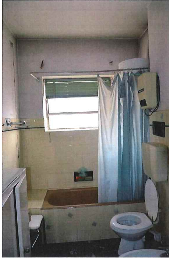
5. bagno sud finestrato
