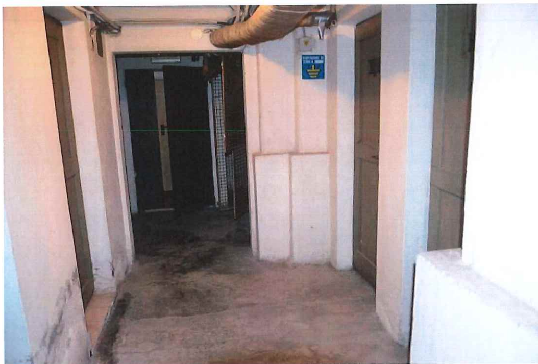
23. corridoio accesso cantine
