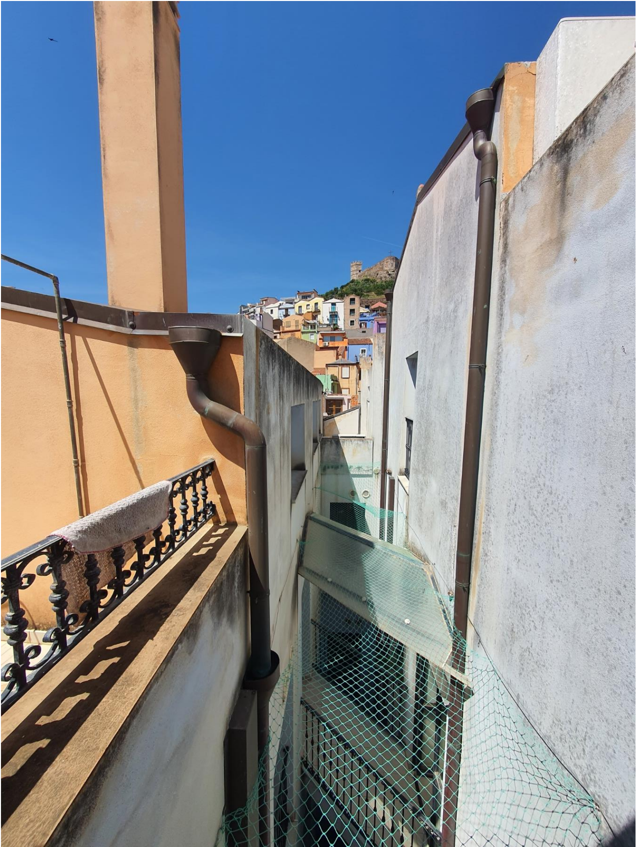
VISTA SUL CAVEDIO PIANO QUARTO
