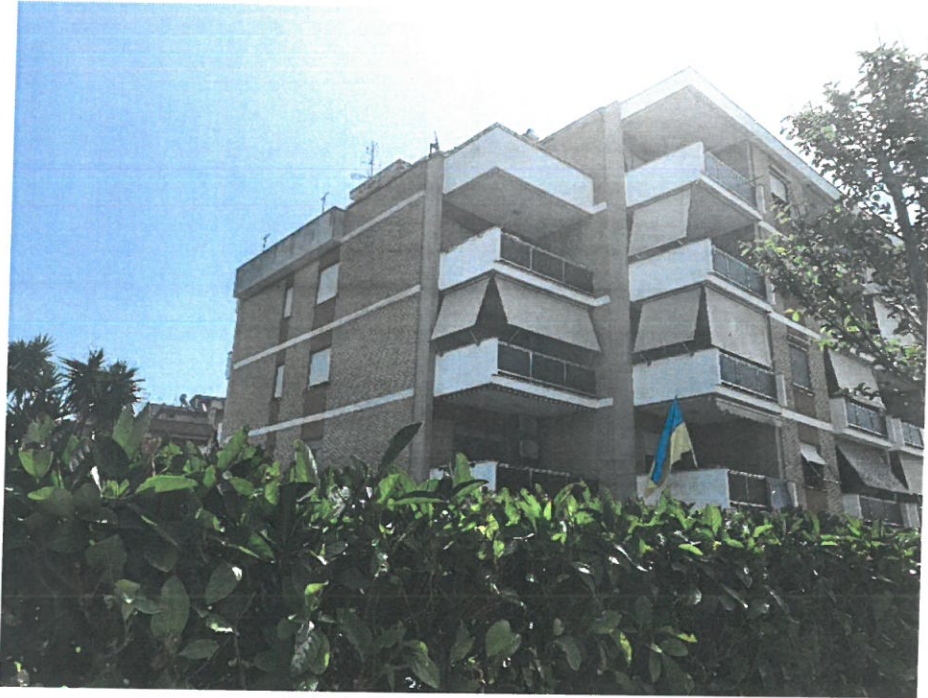
Foto 1: Vista prospetto fabbricato
